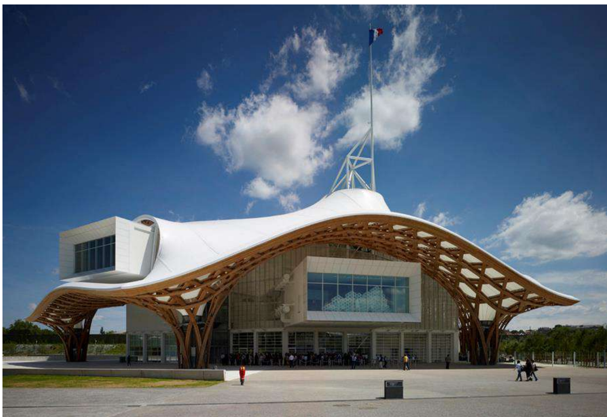
Figura 32. Vista frontal del Centro Pompidou. Fotografía de © Didier Boy De La Tour.
