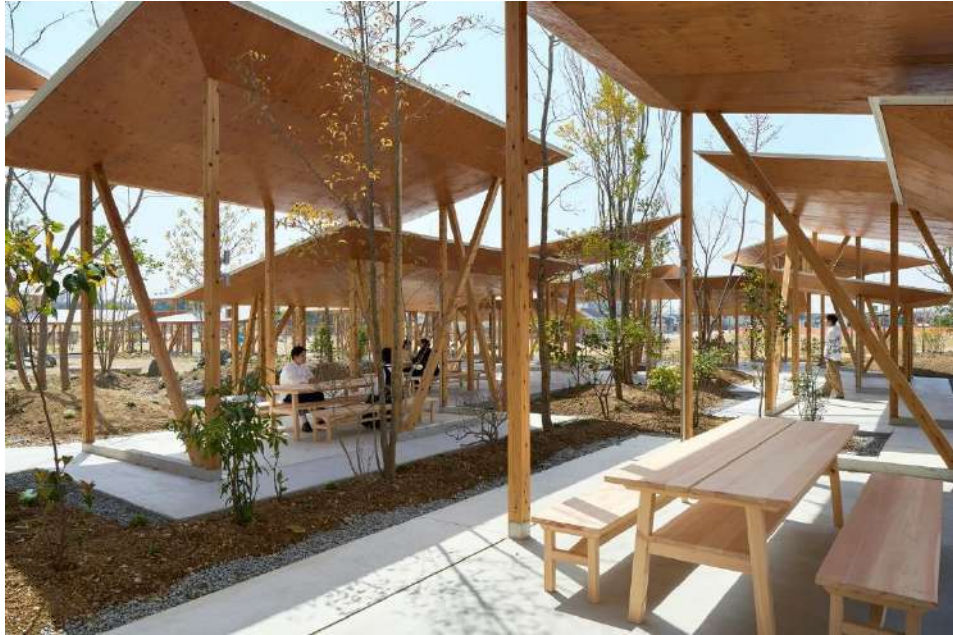
Ilustración 11 Instalación Base del parque Baraike, Tomohiro Taka Architects, Osaka, Japón (2022) Fuente: https://www.archdaily.com/984707/baraike-park-base-facility-tomohiro-hata-architect-and-associates . Elaborada por Toshiyuki Yano
