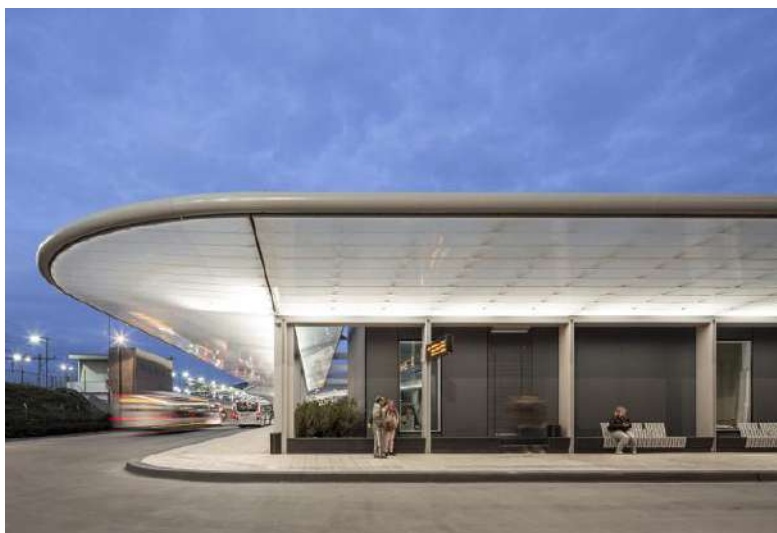
Ilustración 5: Toldo del proyecto Bus Station Tilburg.
