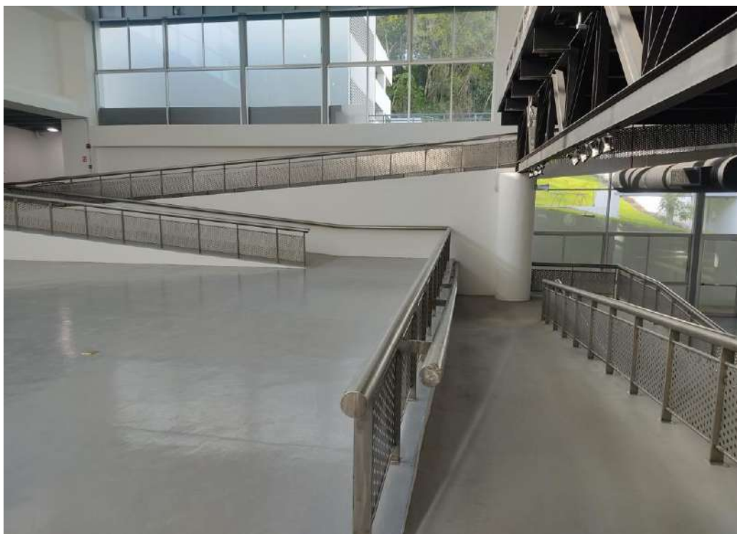
Ilustración 48 Vista de circulación, nivel artes plásticas. Ciudad de las Artes. Tomada por el autor.
