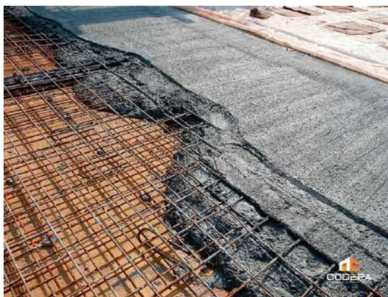
Figura 74. Losa de Concreto Armado. Fuente: Internet
