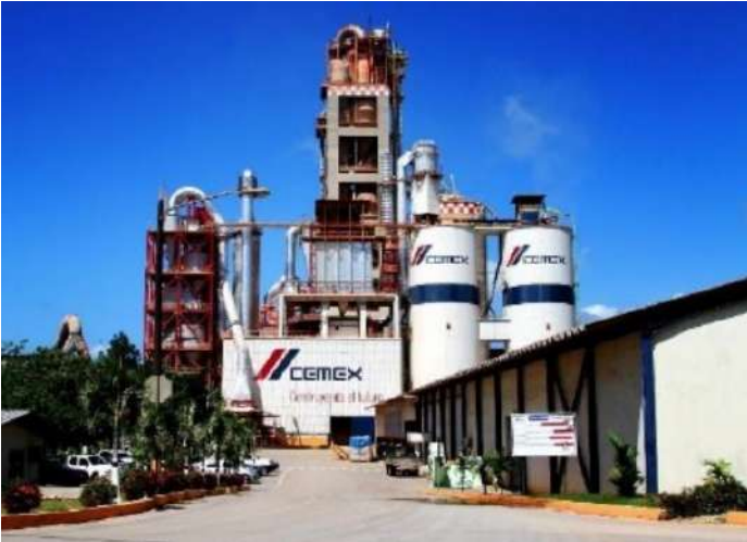
Figura 20. Fábrica de Cemento. Fuente: Internet
