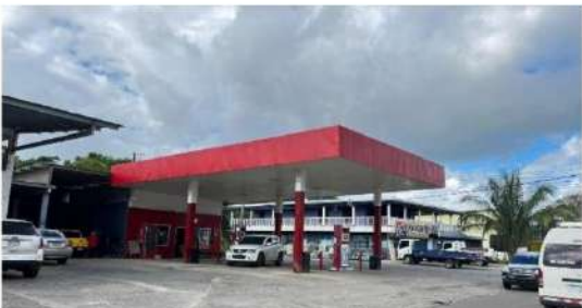
10. Estación de gasolina "El Porvenir"
