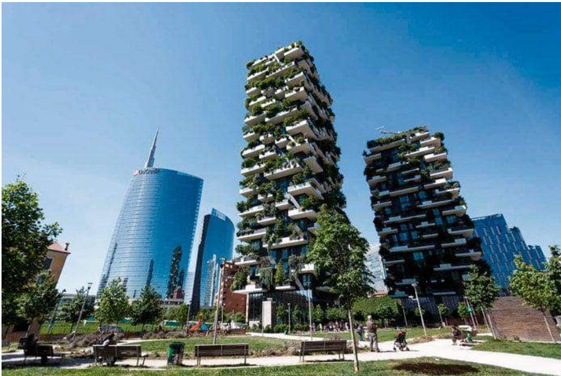
Imagen 8. Vista del Edificio Bosco Verticale, Stefano Boeri
