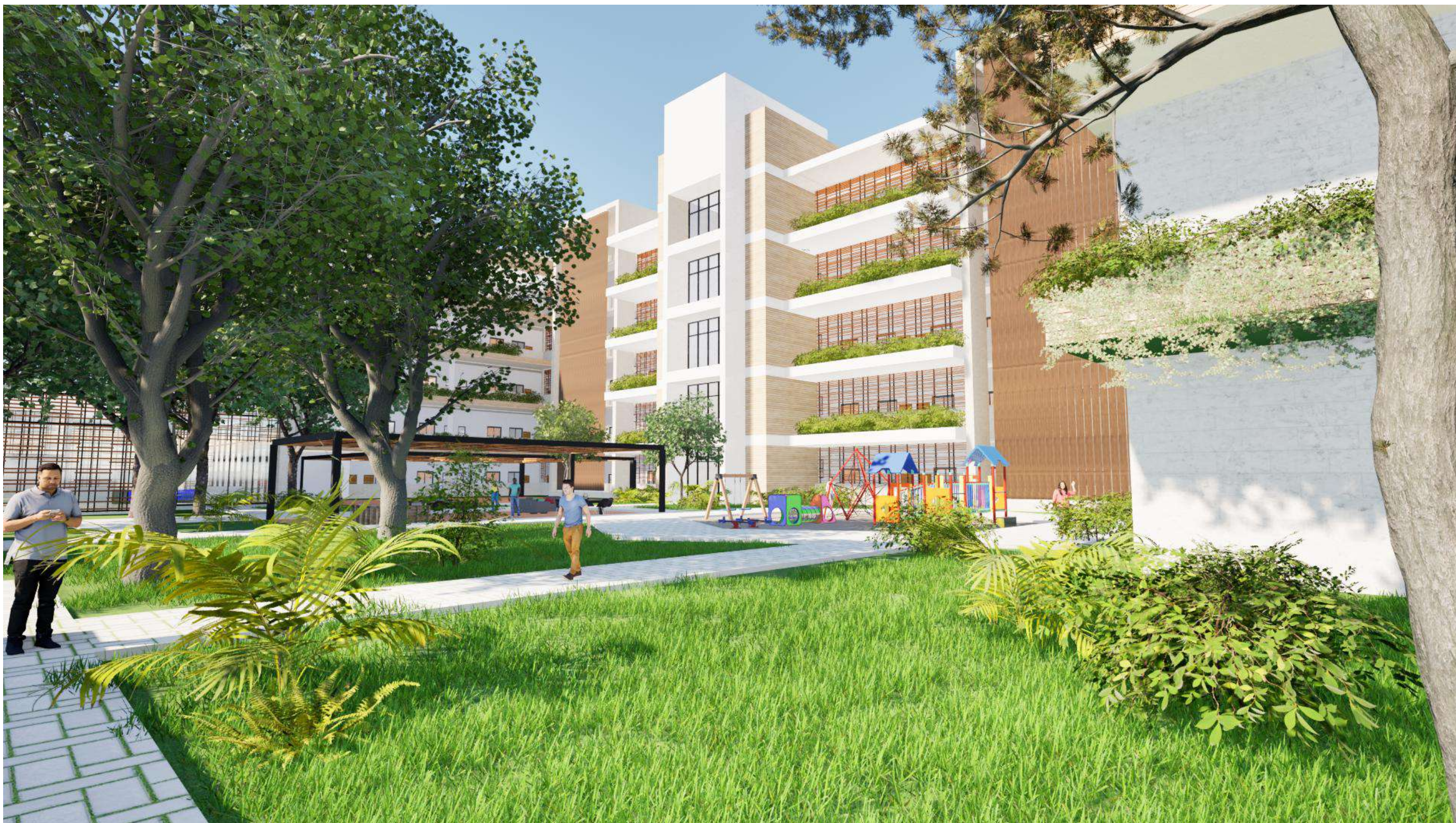
Imagen 57. Vista de Edificio Apartamentos.
