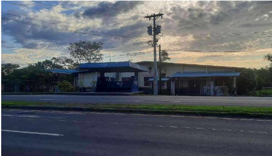
Figura 28. Centro de salud en el Corregimiento de Chame. Fuente: Propia.
