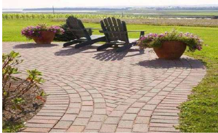
Figura 60. Instalación de adoquines. instalación de adoquines de concreto Residencial y Comercial. Fuente: (Bloques Constructora, 2025).
