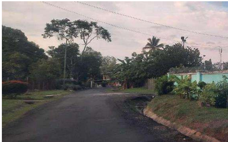
Figura 27. Cunetas abiertas en el corregimiento de Chame. Fuente: Propia.
