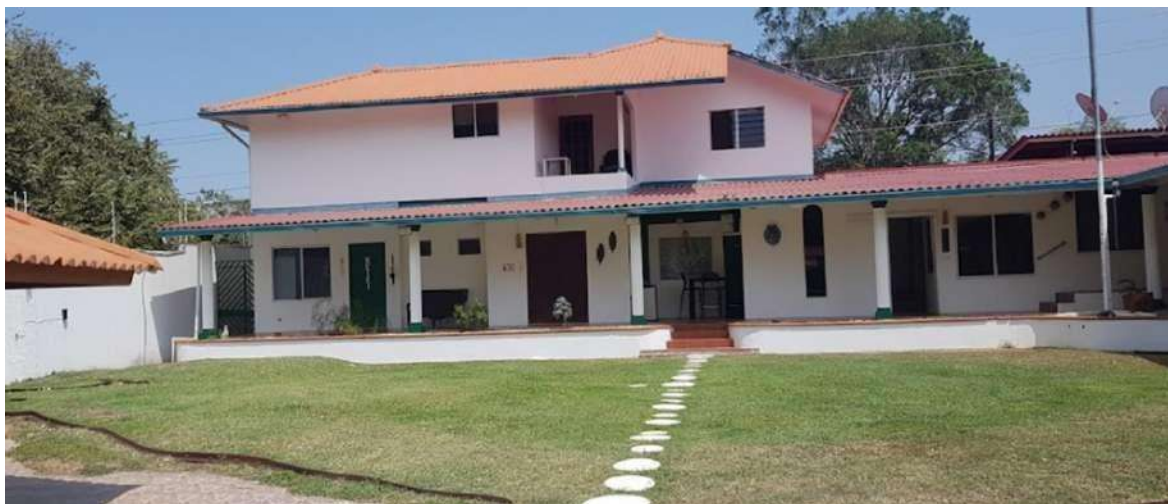
Figura 19. Vista Este con el Consultorio Médicos Coronado. Fuente: Propia.
