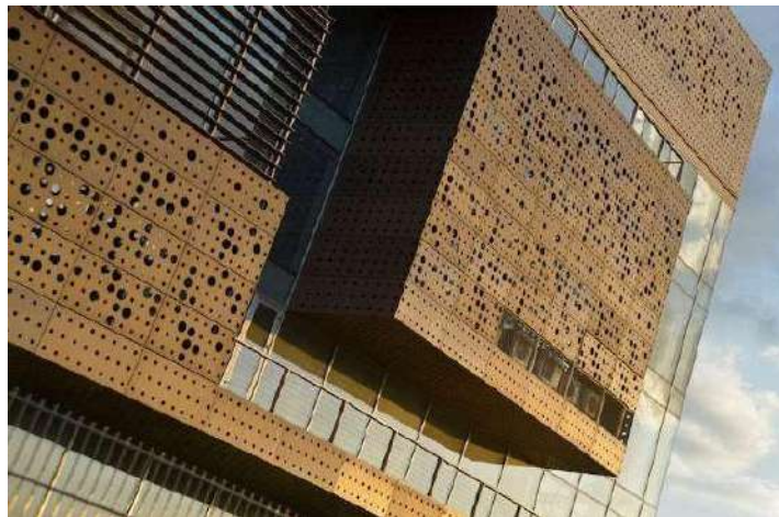
Figura 57. Fachadas con diseños contemporáneos. Acero perforado. Fuente: (SCA Solutions, 2020).
