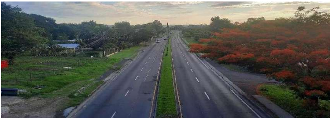
Figura 13. Vista de la carretera Panamericana en el Corregimiento de Chame. Fuente: Propia.
