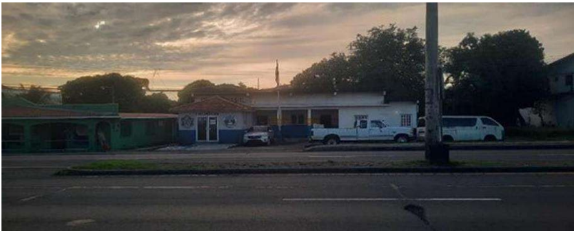
Figura 32. Estación de policía en el Corregimiento de Chame. Fuente: Propia.
