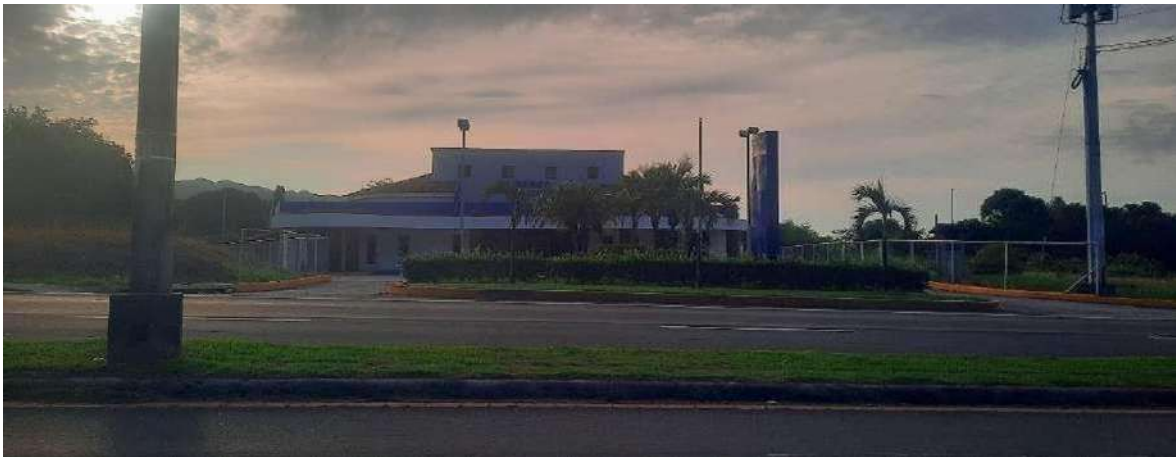
Figura 31. Banco Nacional en el Corregimiento de Chame. Fuente: Propia.
