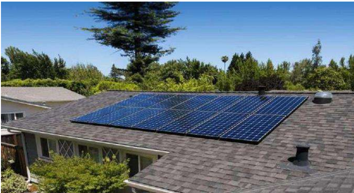
Figura 64. Montaje de paneles solares. Fuente: (Sunvena, 2024).
