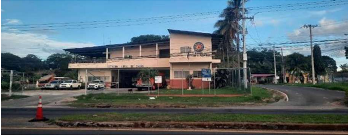
Figura 30. Estación de Bomberos en el Corregimiento de Chame. Fuente: Propia.
