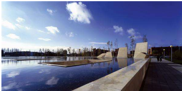
Ilustración 49: techo del recinto
