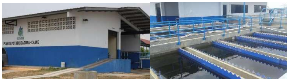
Ilustración 158: Potabilizadora de Chame. Extraída de https://www.tvn-2.com/nacionales/provincias/potabilizadora-chame-operara-julio-mantenimiento_1_1990329.html
