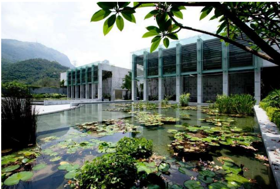
Ilustración 38: estanques en la parte frontal del edificio
