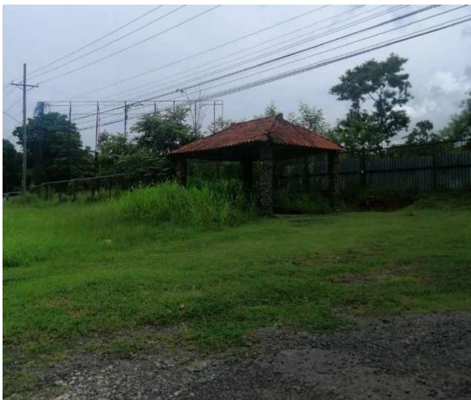
Ilustración 161: foto antes de llegar al lote donde se observa el escaso mobiliario urbano. Fuente: elaboración propia
