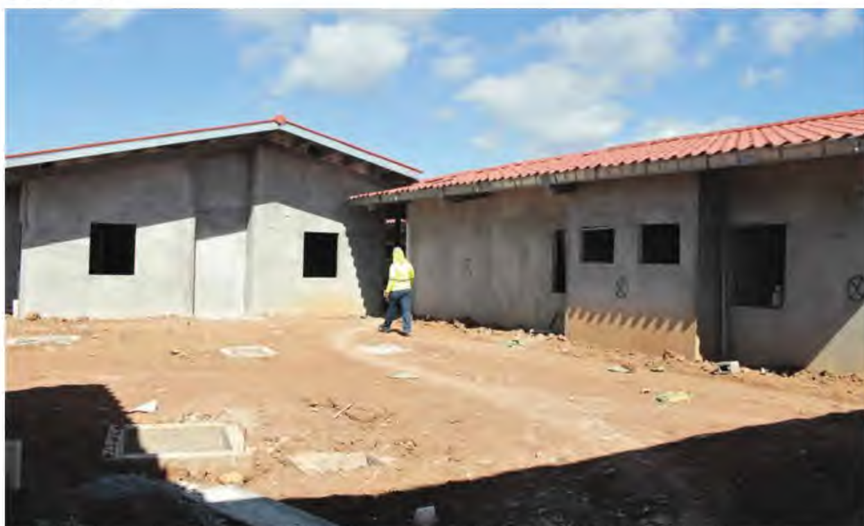
Ilustración 32: Fotografía del Centro de Capacitación y Entrenamiento del Órgano Judicial en su etapa de construcción. Fuente: https://www.organojudicial.gob.pa/noticias/magistrados-de-la-csj-visitan-proyecto-en-construccion-del-centro-de-capacitacion-en-el-distrito-de-santa-maria
