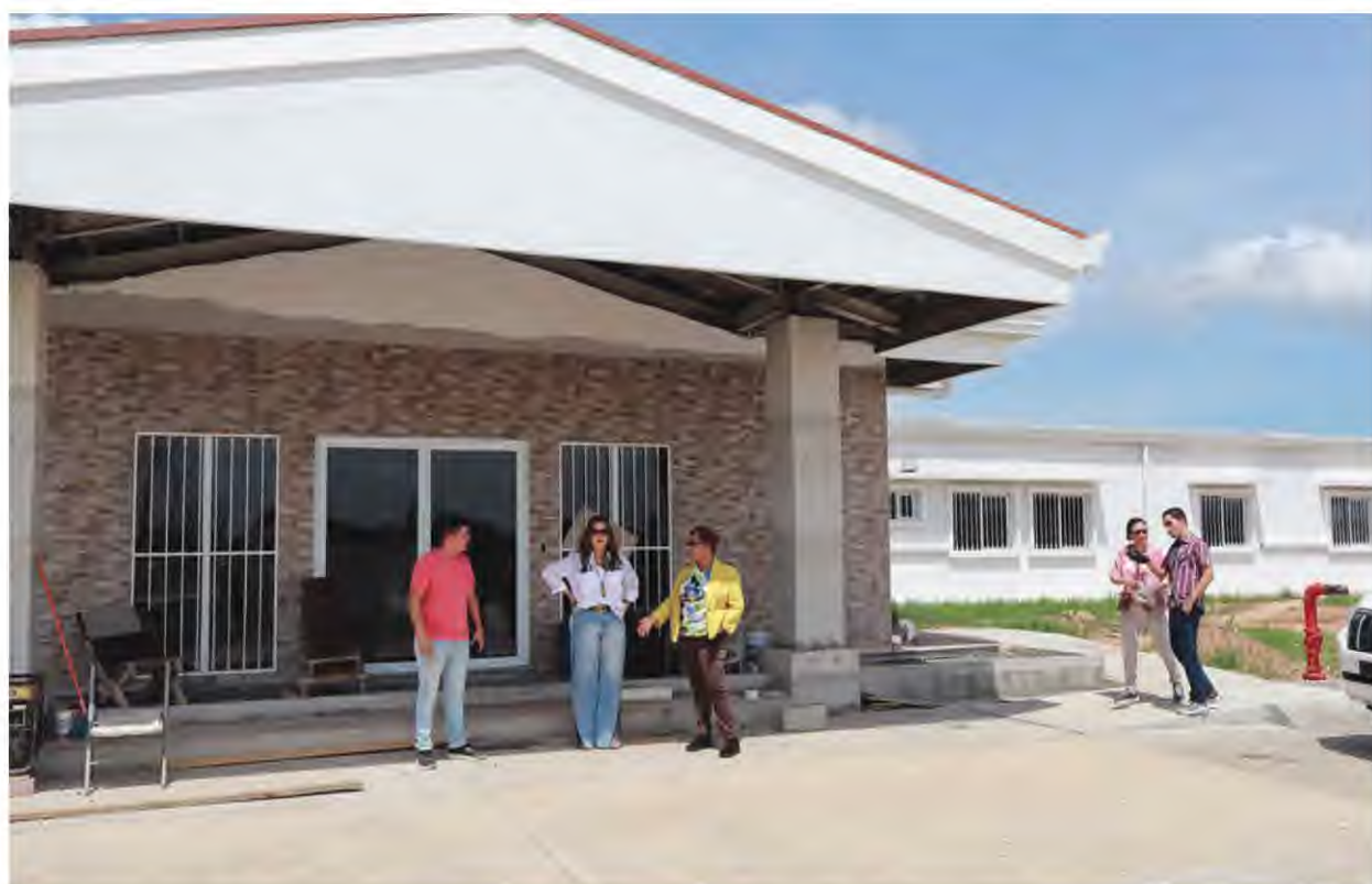
Ilustración 30: Fotografía del Centro de Capacitación y Entrenamiento del Órgano Judicial en su etapa de construcción. Fuente: https://www.organojudicial.gob.pa/noticias/servidores-judiciales-realizan-gira-de-trabajo-por-las-provincias-de-herrera-y-los-santos-para-su-pervisar-avances-de-obr
