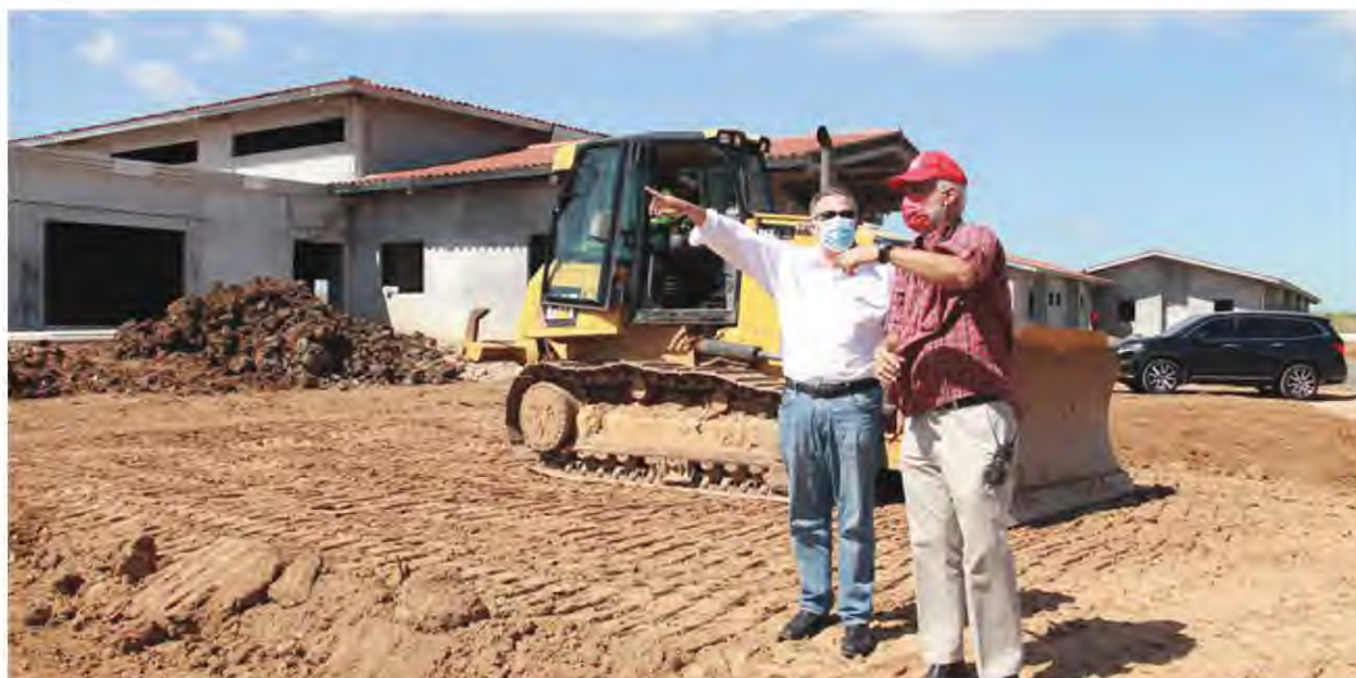
Ilustración 31: Fotografía del Centro de Capacitación y Entrenamiento del Órgano Judicial en su etapa de construcción. Fuente: https://www.organojudicial.gob.pa/noticias/magistrados-de-la-csj-visitan-proyecto-en-construccion-del-centro-de-capacitacion-en-el-distrito-de-santa-maria
