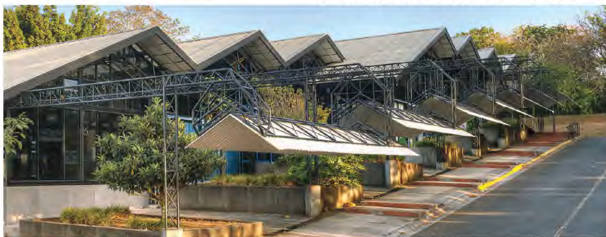
Ilustración 45: BAC BANCO CURRIDABAT. Fuente: https://www.archdaily.cl/cl/999212/arquitectura-tropical-una-arquitectura-a-la-luz-de-la-sombra/64342192164aca0170801762-arquitectura-tropical-una-arquitectura-a-la-luz-de-la-sombra-imagen?next_project=no
