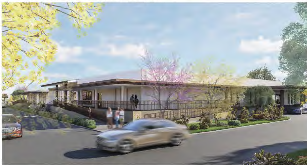
Ilustración 184: Perspectiva exterior - Edificio II. Fuente: Por la autora.
