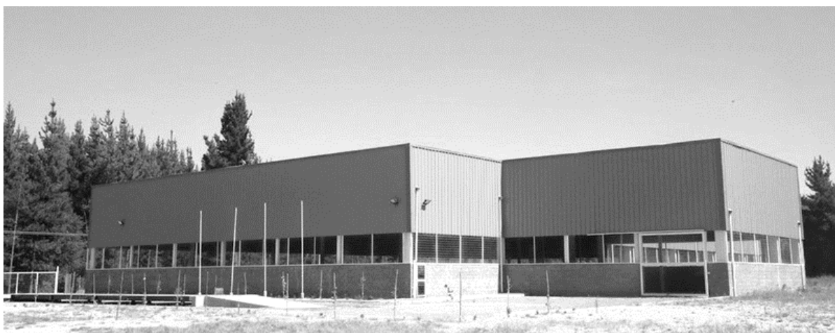
Ilustración IL_ 20: Almacén de compostaje de la planta de reciclaje y compostaje Santa Juana.
