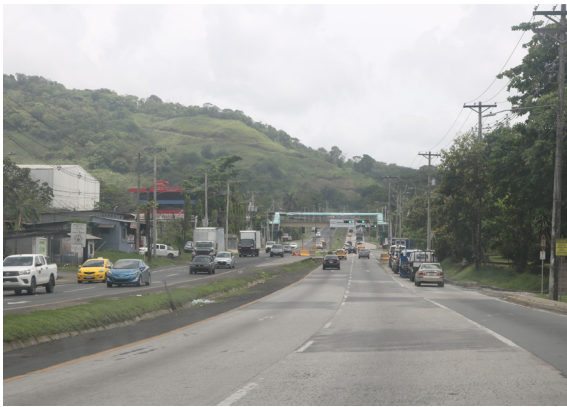
Vista de Carretera transistmica - Vía pública
