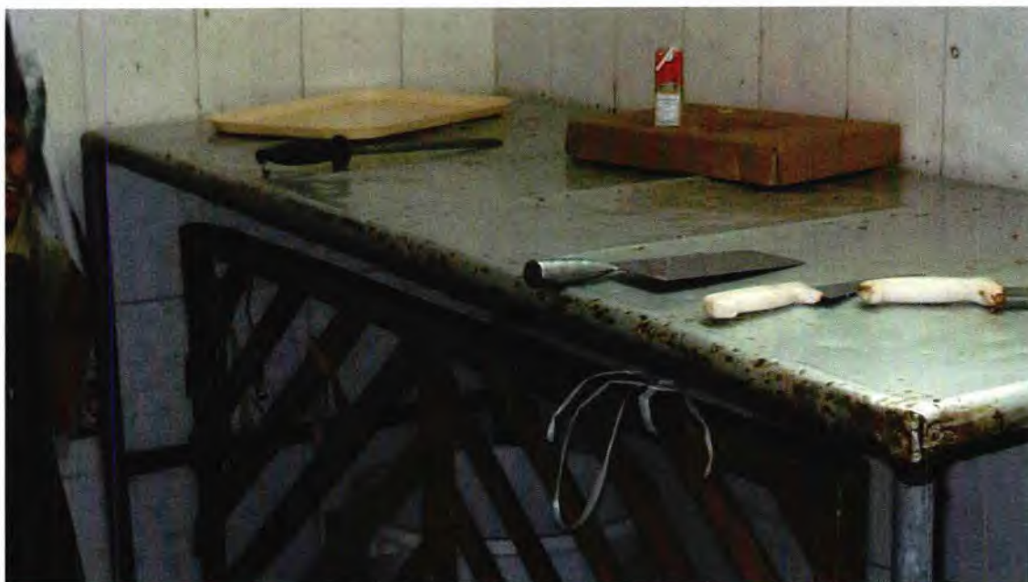
Figura 49. Mesa de aluminio que no está en buen estado (Tienen oxido)
