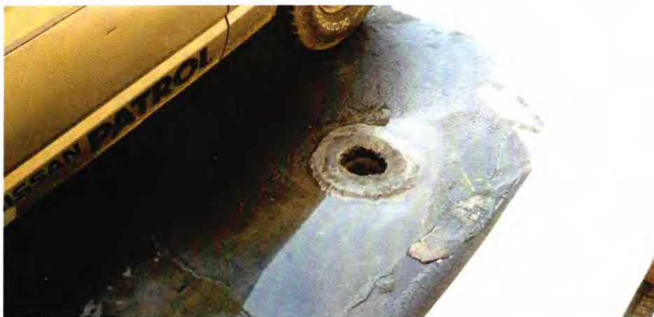
Figura 31. Resumidero sin trampa en las parte de afuera del mercado
