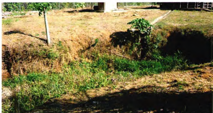
Figura 24. Canales de aguas residuales del matadero de La Peña
