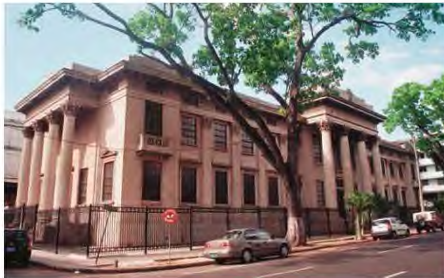
Fotografía 4. Edificio de Archivos Nacionales, con su impresionante fachada Neoclásica, Barrio La Exposición, Ciudad de Panamá. Fuente: Berrío-Lemm, 2013.
