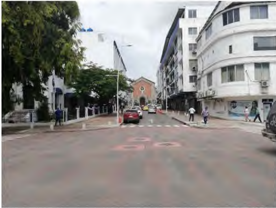
Fotografía 16. Vista a la Iglesia Don Bosco, foto tomada desde el Parque Porras. Fuente: Dioseline Camargo
