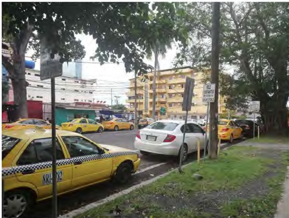
Fotografía 22. Señalética no visualmente accesible por la falta de mantenimientos de los árboles. Fuente: Dioseline Camargo
