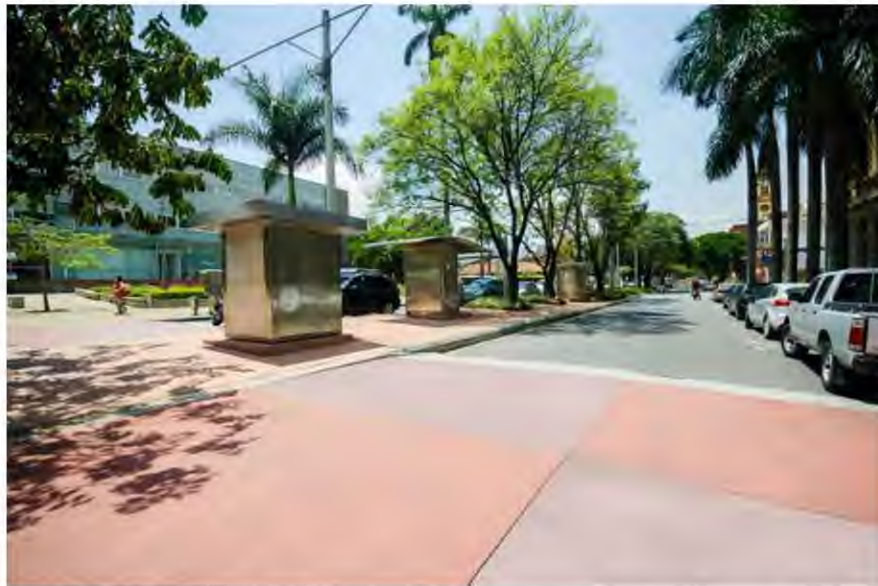
Fotografía 33. Acabado de aceras con concreto de color. Fuente: Argos, s.f.
