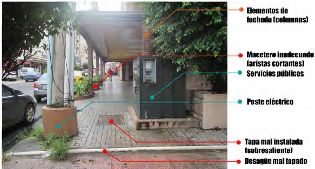
Imagen 19. Elementos existentes. Fuente: Dioseline Camargo
