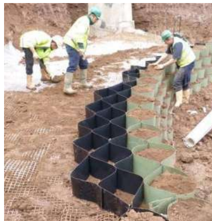
Imagen 73: Proceso de construcción de un muro de contención con geoceldas. Fuente: https://abg-geosynthetics.com/es/products/geocells/webwall-geocell/
