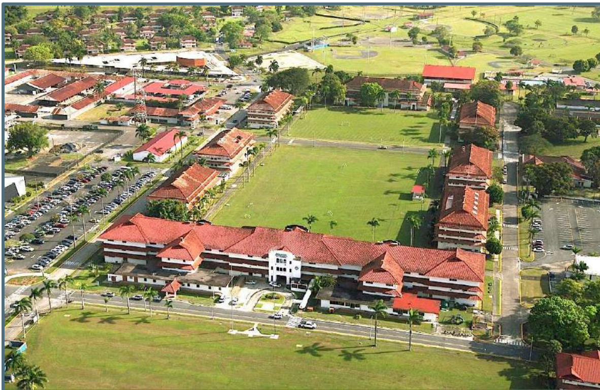
Imagen 17: Vista aérea de la Ciudad del Saber, Albrook, Ancón.
