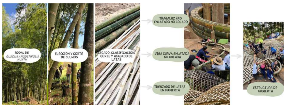
Figura 25. Procesos constructivos con bambú. Ejemplo 3: Guadua angustifolia en Casa de Campo, Antioquia, Colombia.
