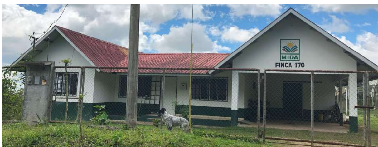
Figura 156. Edificación existente. Semillero del MIDA.
