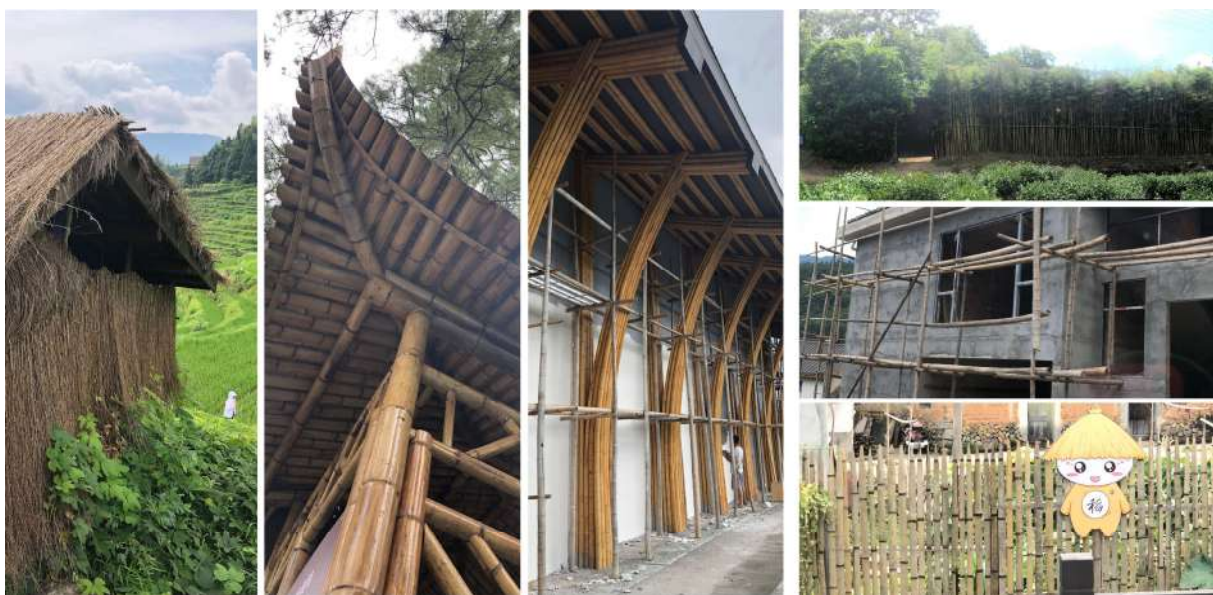
Figura 48. Arquitectura con bambú en Zhejiang.
