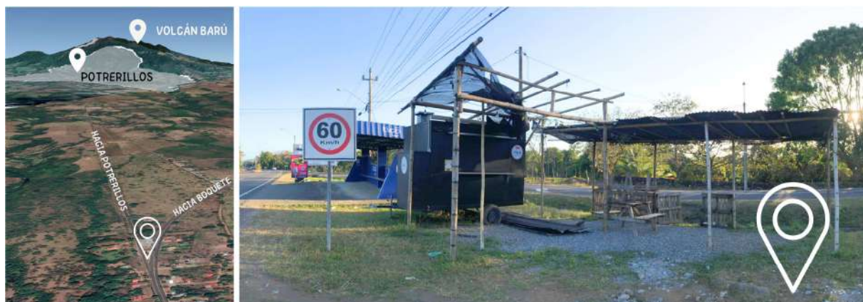
Figura 86. Estructura temporal hecha con bambú en vía hacia Potrerillos.
