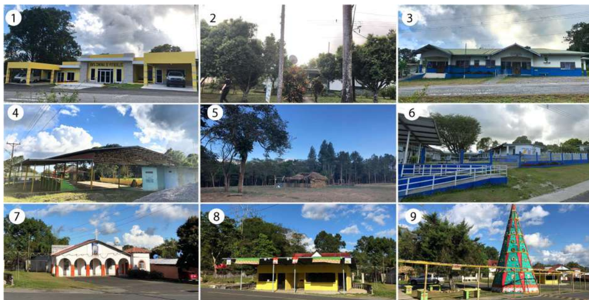
Figura 89. Arquitectura de Potrerillos Arriba y edificios principales.
