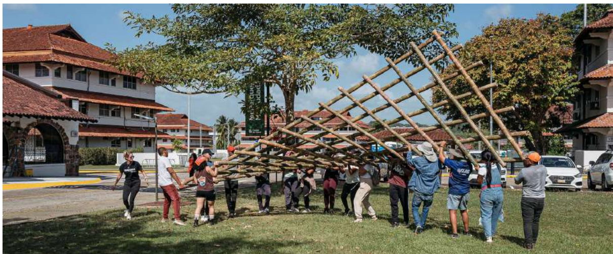
Figura 76. Montaje de una de las piezas de Pabellón Bambú Lab, en Festival Transversal 2024: el primer Festival de Arquitectura y Diseño de Panamá en Ciudad del Saber. Adaptado de: Alfredo Martiz (comunicación personal 2024).
