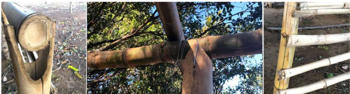
Figura 112. Uniones utilizadas en la construcción de estructuras temporales en la Feria de Potrerillos 2023.
