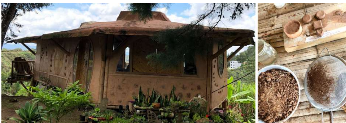
Figura 43. Construcción con tierra del sitio. Casa de campo.
