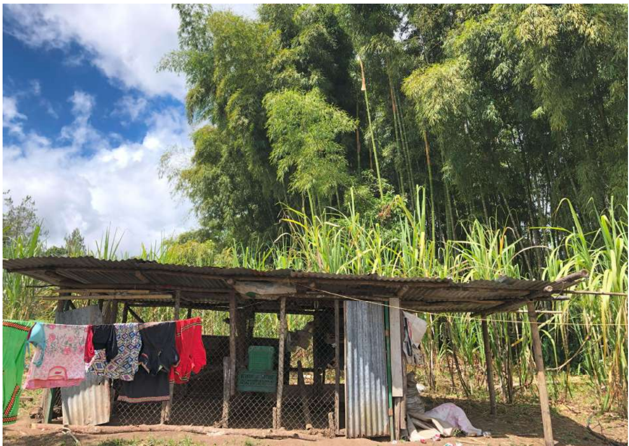
Figura 113. Bambú: planta y material constructivo, en una vivienda de Potrerillos Arriba.
