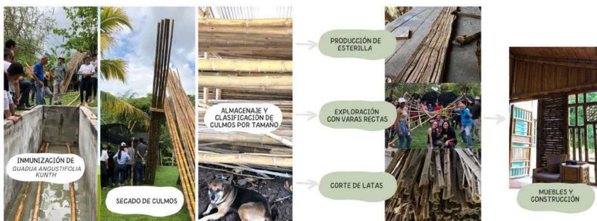
Figura 24. Procesos constructivos con bambú. Ejemplo 2: Guadua angustifolia en Finca Rodaisa, Panamá.
