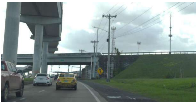
Imagen 49. Tramo hacia la estación Hospital del Este.
