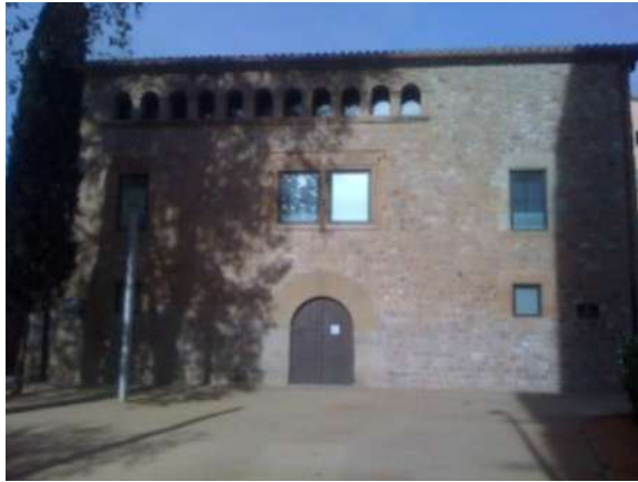
Figura 4. Edificio L'Harmonia. Fuente: https://www.arquitecturasostenible.org/
