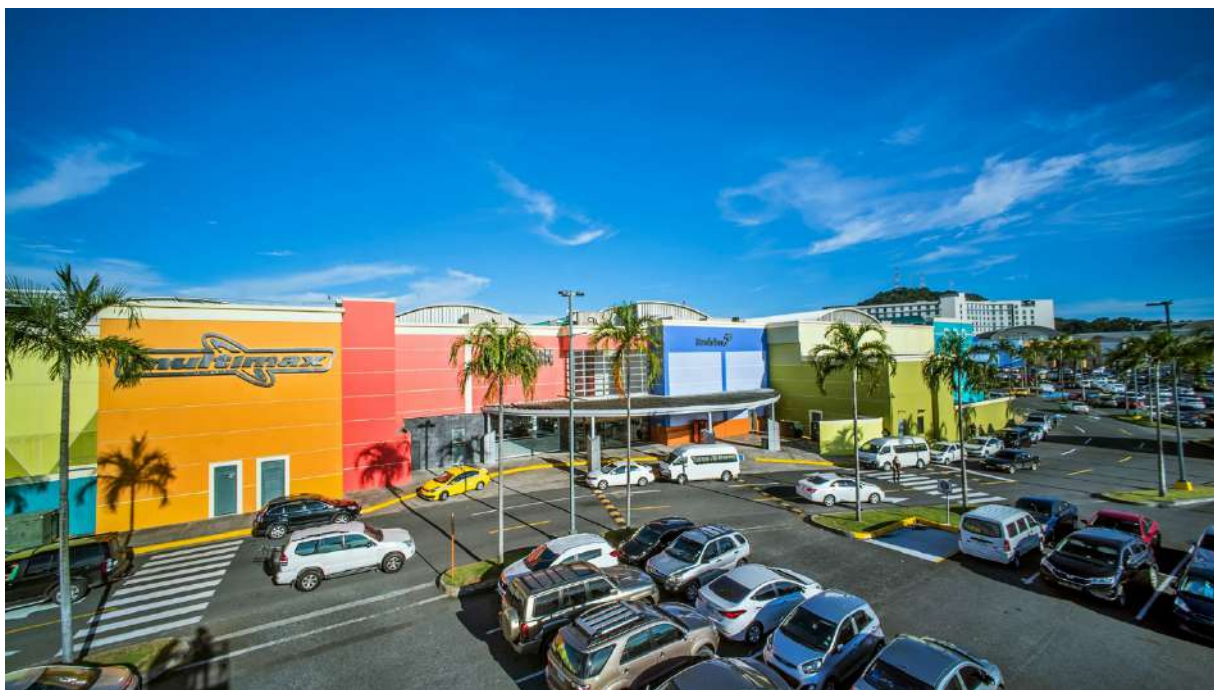
Figura 26. Centro Comercial Albrook Mall. Fuente: https://www.glp.com.pa/proyecto/albrook-mall/
