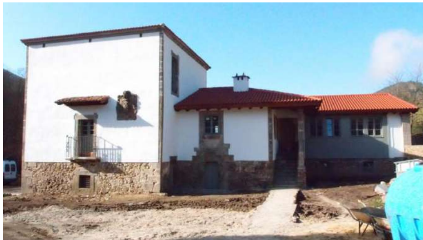
Figura 6. Rehabilitación del Palacio de Arganza. Fuente: https://www.construction21.org
