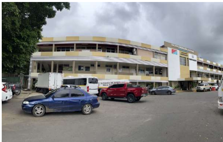
S. Arce (2023). Fotografía de la fachada frontal del Palacio Municipal 10.11.2023. [ilustración 4]
