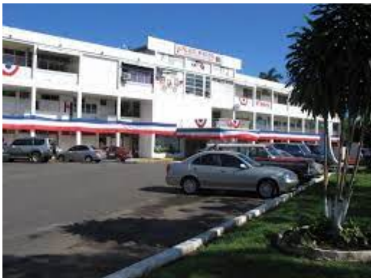
S. Arce (2023). Fachada frontal del Palacio Municipal de David, Chiriquí, Año 2011 [ilustración 2]
