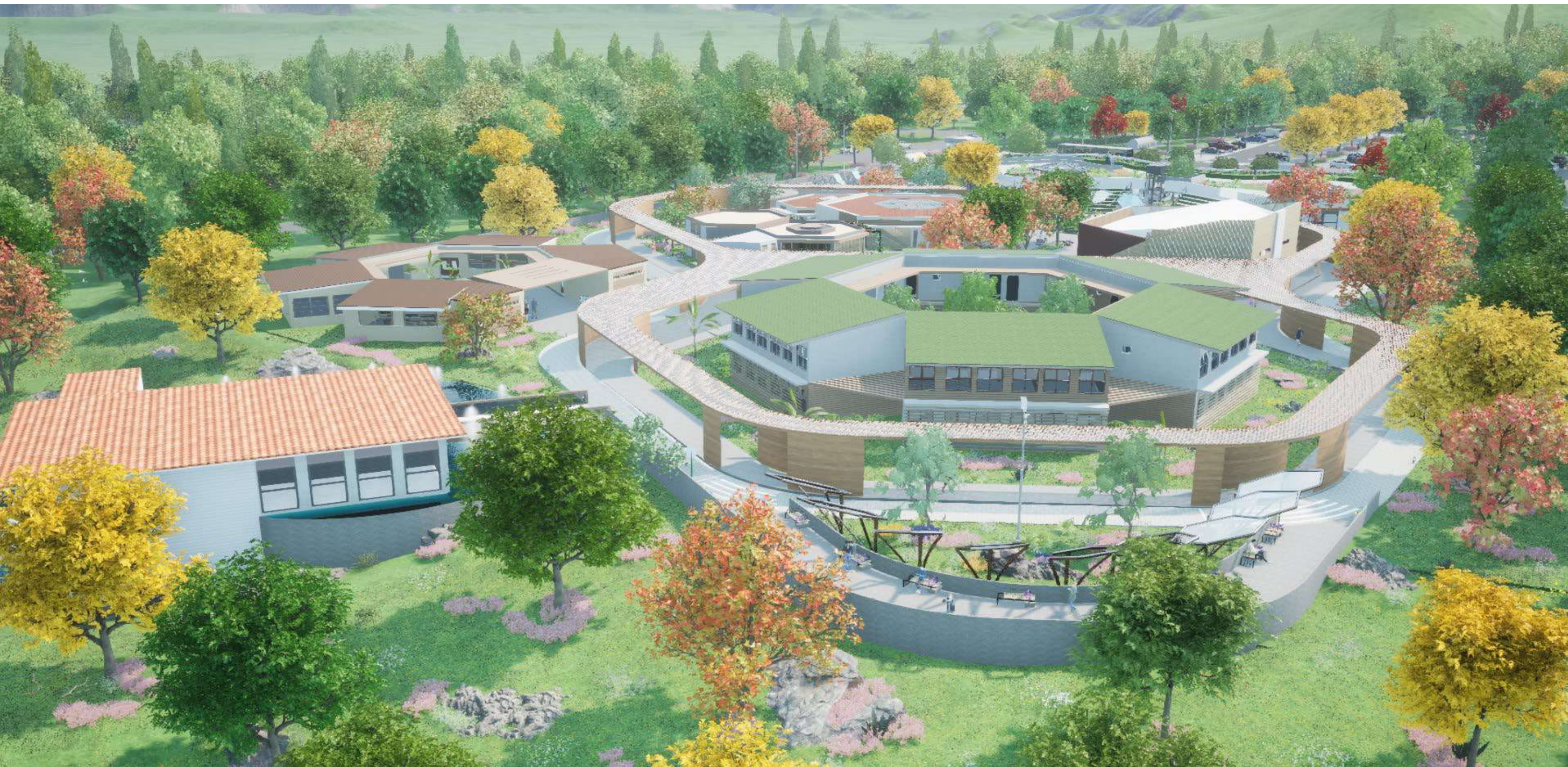
Ilustración 83 //Vista exterior posterior del conjunto. Fuente: Elaborado por el autor.
