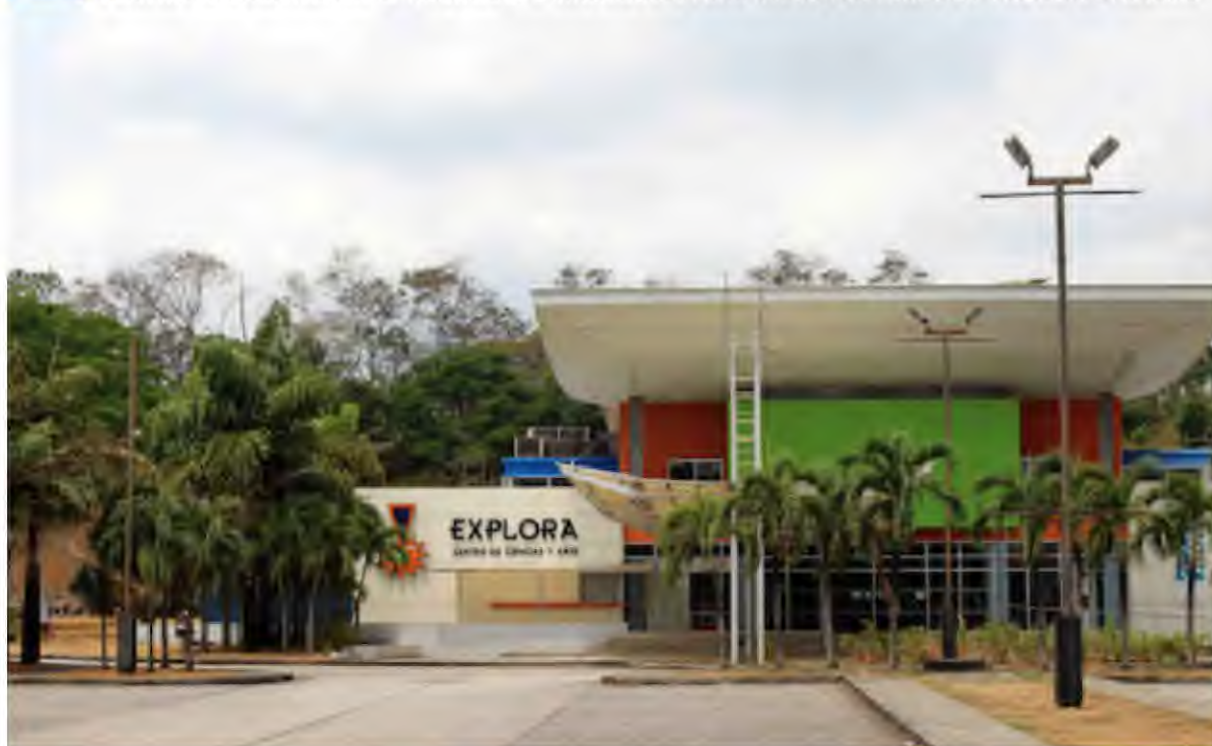
Ilustración N° 1: Fotografía de la fachada frontal del Centro EXPLORA, Panamá. Explora sin fronteras, Innova Communications Inc. © 2016.
