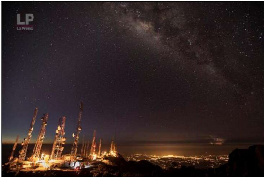
Ilustración 57- Vista nocturna del área de antenas en la cima del volcán Barú
