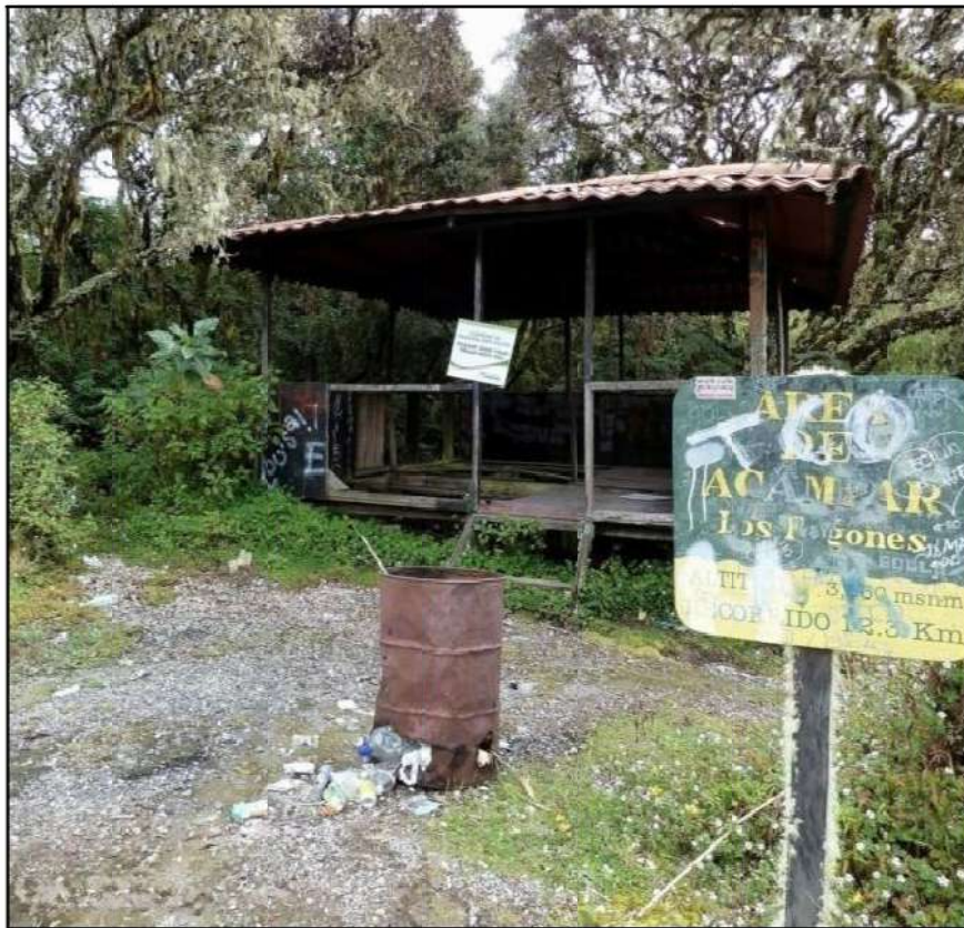
Ilustración 50- Refugio en deterioro- área Los Fogones
