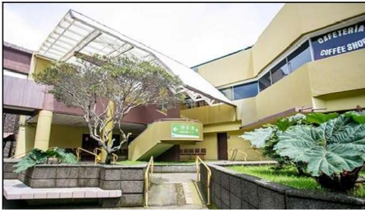
Ilustración 20-Edificio centro de Visitantes Volcán Poás
