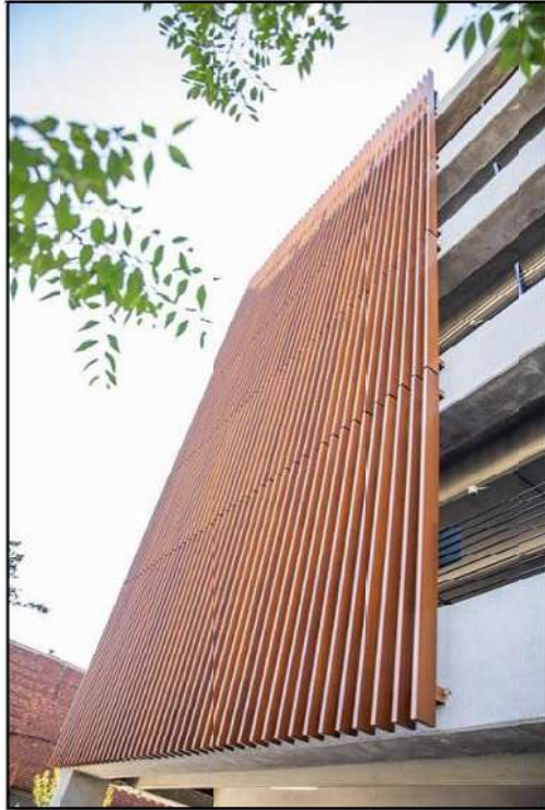
Ilustración 143-Celosías de Aluminio
