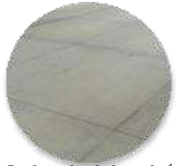
Pavimento de hormigón
