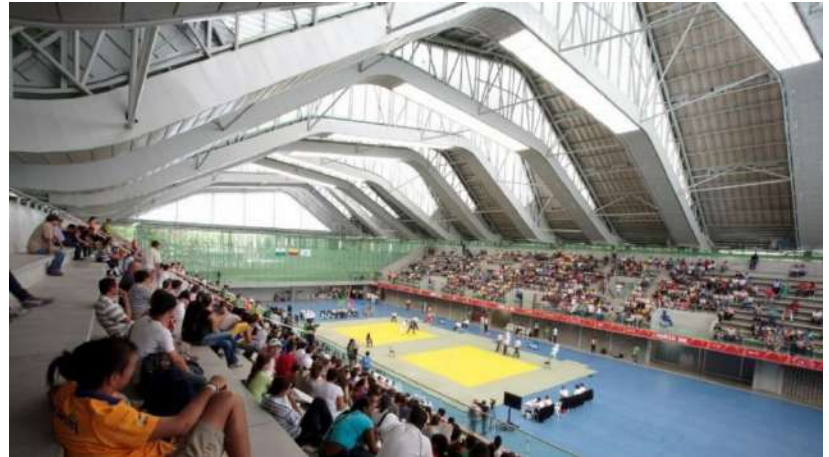
Ilustración 34 | vista interna de estadio | Fuente: Archdaily
