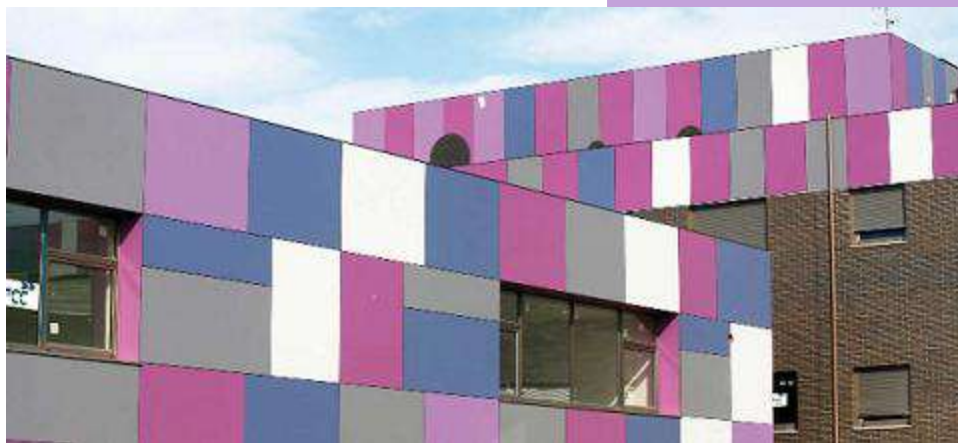
Figura 15. Vista exterior del proyecto “La Casa Malva”.
