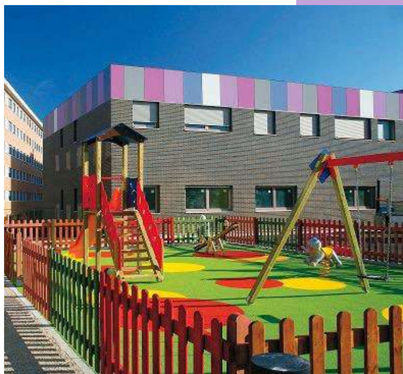
Figura 16. Vista exterior del proyecto “La Casa Malva”.
