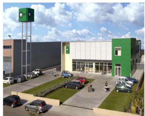
Nota: Fachada frontal de hospital. Fuente: Internet
