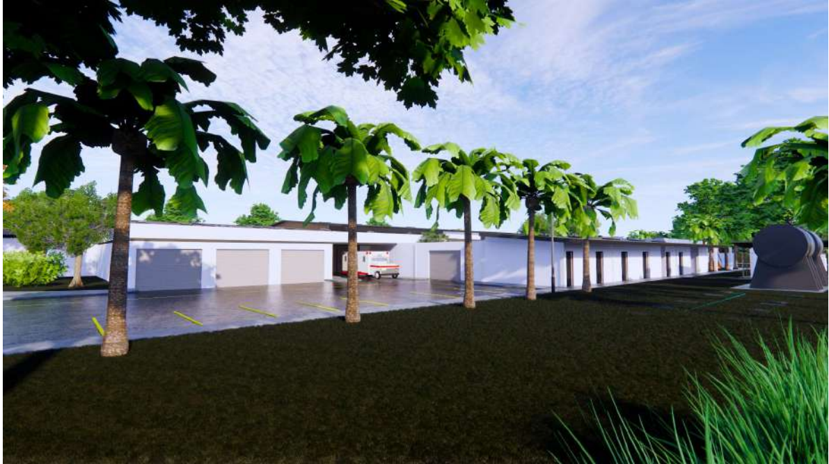
Figura 141 Vista área de depósito y utilidades
