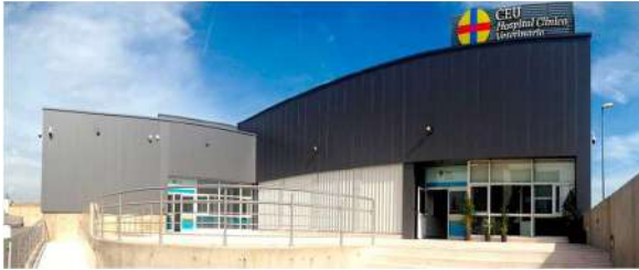
Nota: Fachada frontal de hospital. Fuente: CEU
