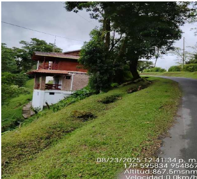
Ilustración 13 Imagen de vivienda en ladera
