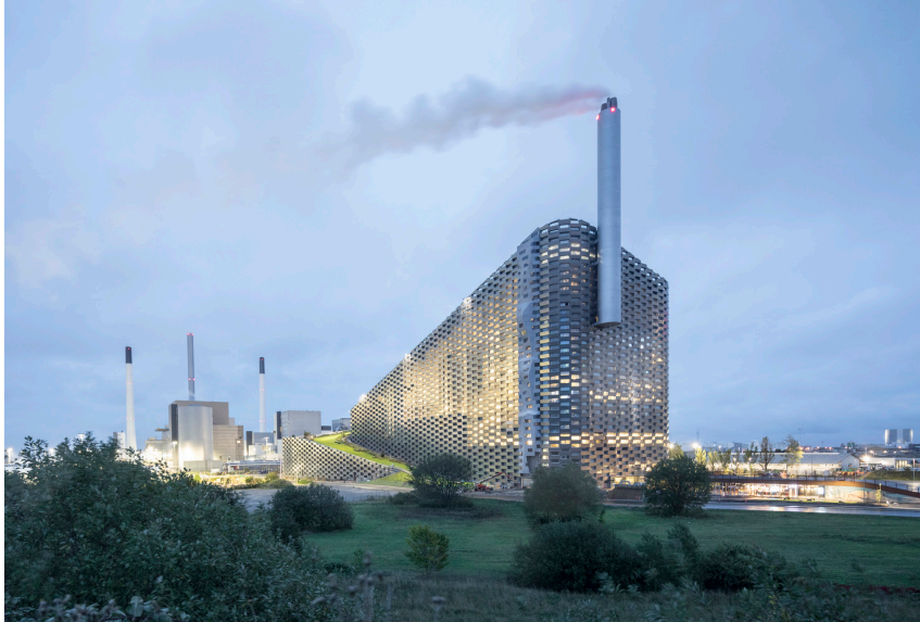
Figura 79: La planta de tratamiento amager
