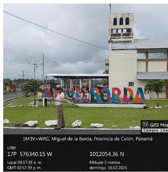
Figura 29 Iglesia situada cerca de áreas de inundación.
