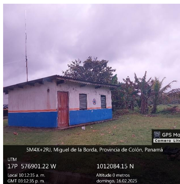
Figura 31 Infraestructura del SINAPROC en condición de abandono.
