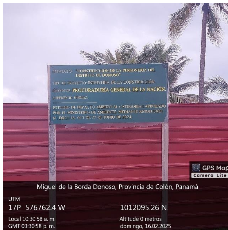
Figura 34 Procuraduría de la Nación en proceso de construcción a orilla de la zona de playa.
