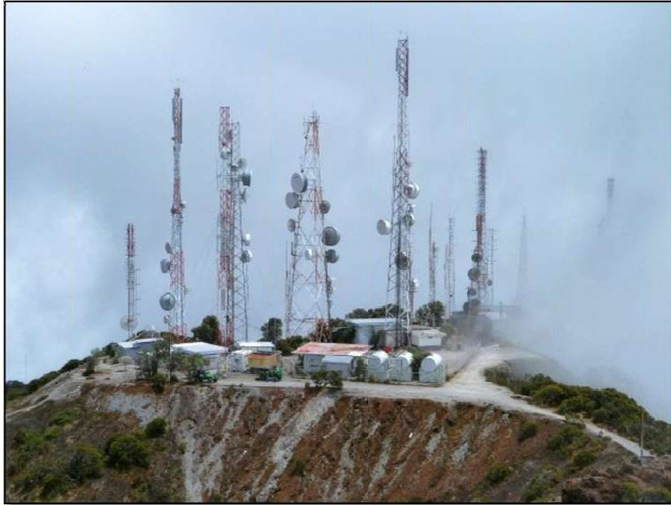
Ilustración 69-SUELO EN AREA DE ANTENAS
