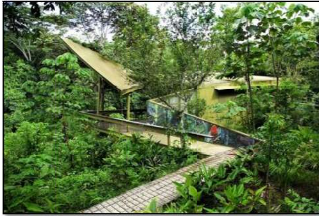
Ilustración 17-Edificio principal del centro de visitantes
