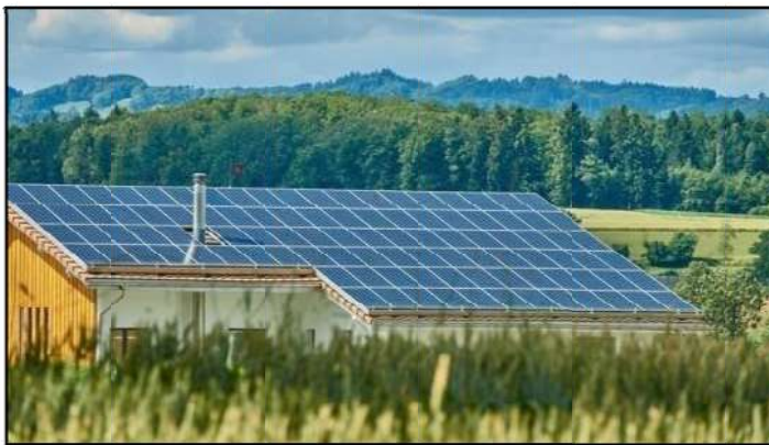
Ilustración 155-Paneles Solares en techos y tejados
