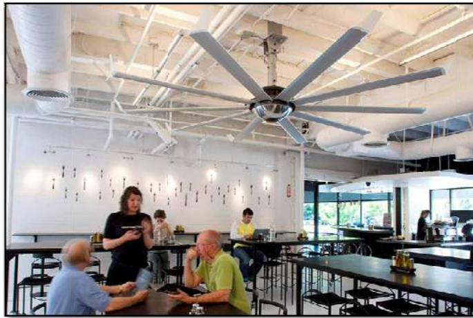
Ilustración 150-Ventiladores para espacios públicos
