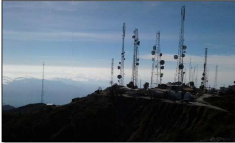
Ilustración 51-Vista General de instalaciones de telecomunicaciones “Las Antenas” Fuente: El Autor
