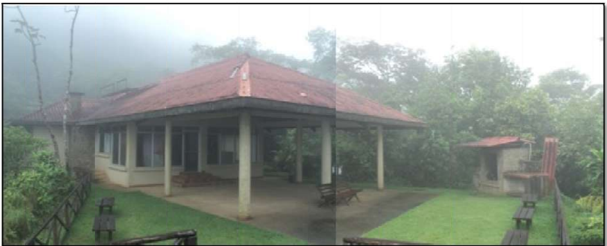
Ilustración 15-Terraza posterior, área de camping y área de BBQ del centro de visitantes Fuente: El Autor
