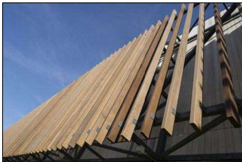
Ilustración 144-Celosías de madera
