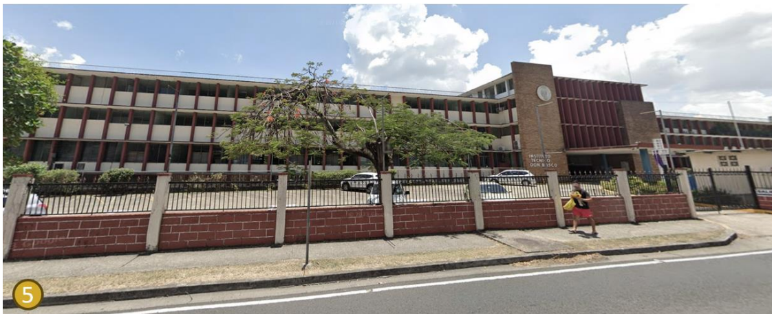
Ilustración 80: Instituto Técnico Don Bosco, Edificio de uso institucional | Foto tomada por: El autor
