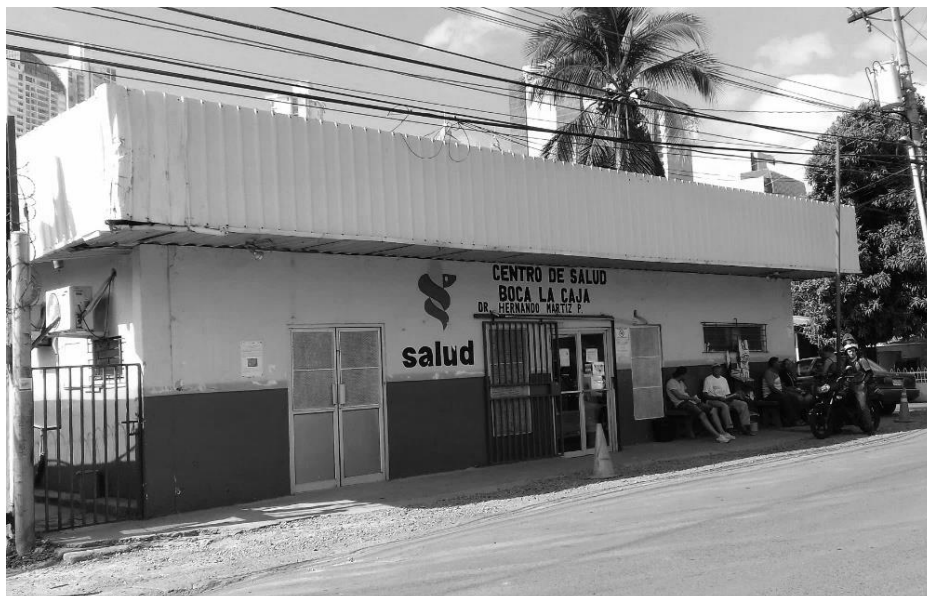
Ilustración 53 - Centro de Salud construido en boca la caja | Foto por: Nervis Araujo (27 de agosto de 2019)
