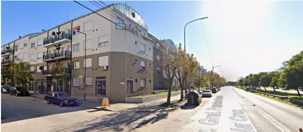
Ilustración 34 - Reurbanización de Villa 20 en la actualidad | Imagen desde: Google Maps - Street View
