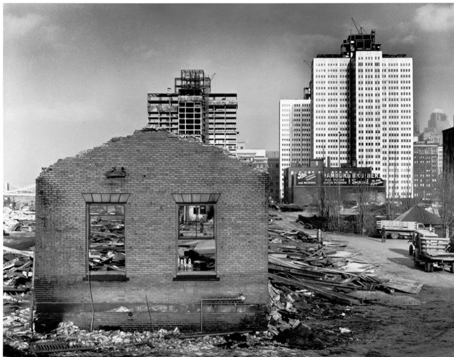
Ilustración 5 : Imagen mostrando la construcción del Gateway Center, referenciado como los inicios de la renovación de Pittsburgh | Imagen obtenida en: ArchDaily
