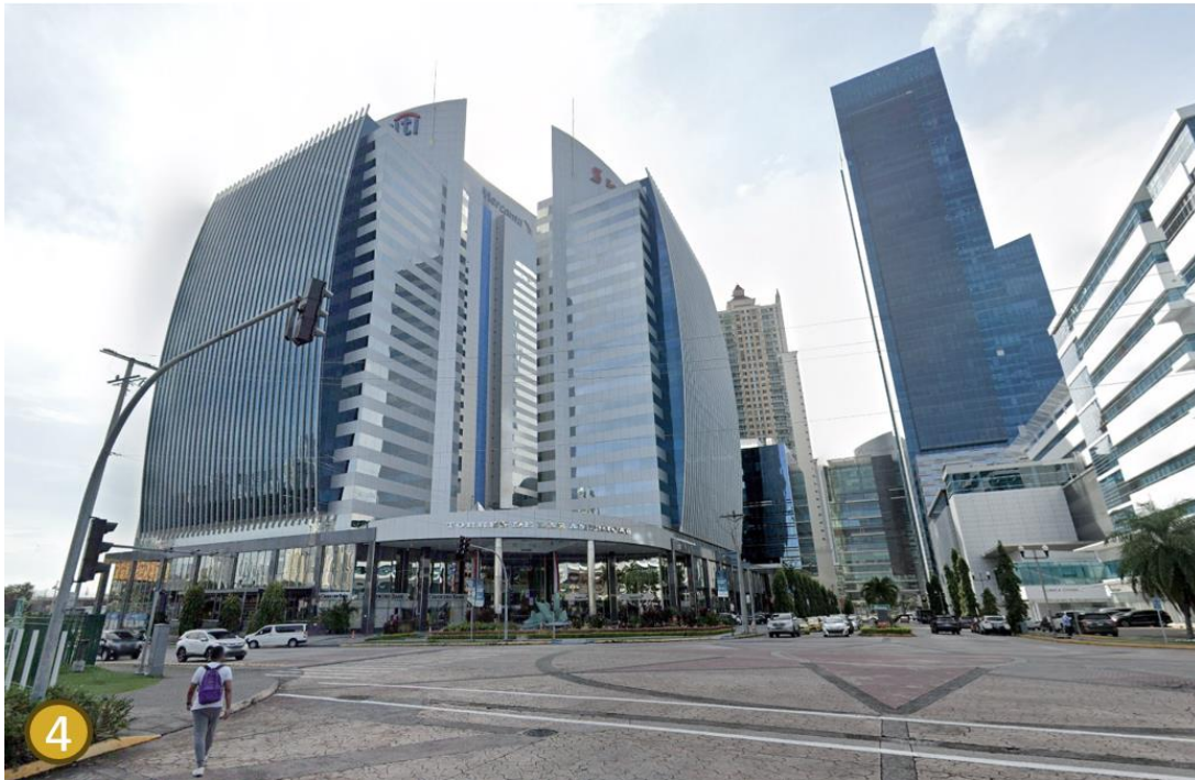
Ilustración 79: Torre de Las Américas, Edificio de uso para oficinas | Foto tomada por: El autor
