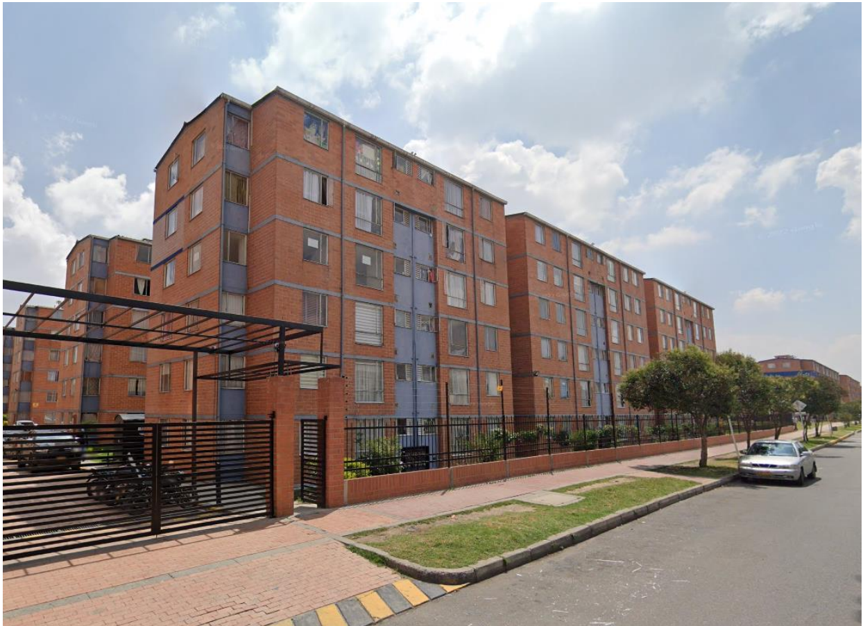
Ilustración 38 - Conjunto Residencial EL Porvenir, Bosa, Bogotá | Imagen tomada de Google Maps
