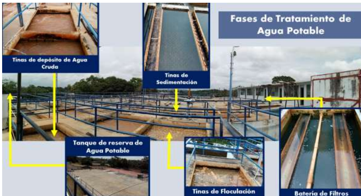
Figura 4. Sistema de tratamiento de la Planta Potabilizadora Jaime Díaz Quintero.
