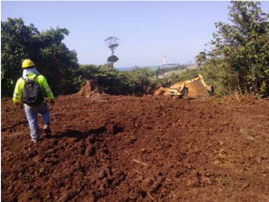
Fotografía 9. Monitoreo de los movimientos de tierra en P6
