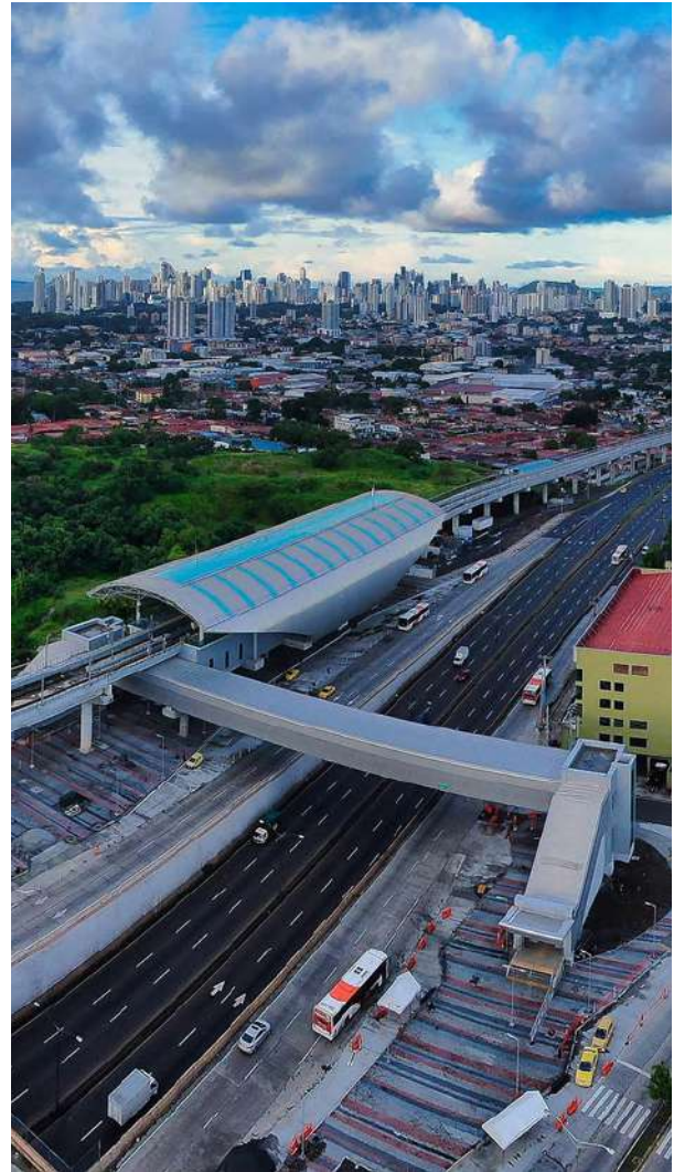
Figura 25. Vista de la Estación Cincuentenario. ©Astrodron
