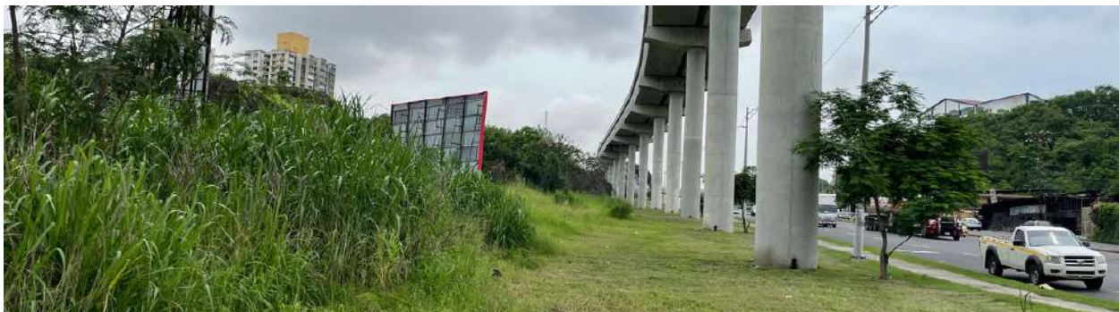
Figura 28. Estructura de la Línea 2 del Metro dentro del retiro frontal del terreno. Elaboración propia.
