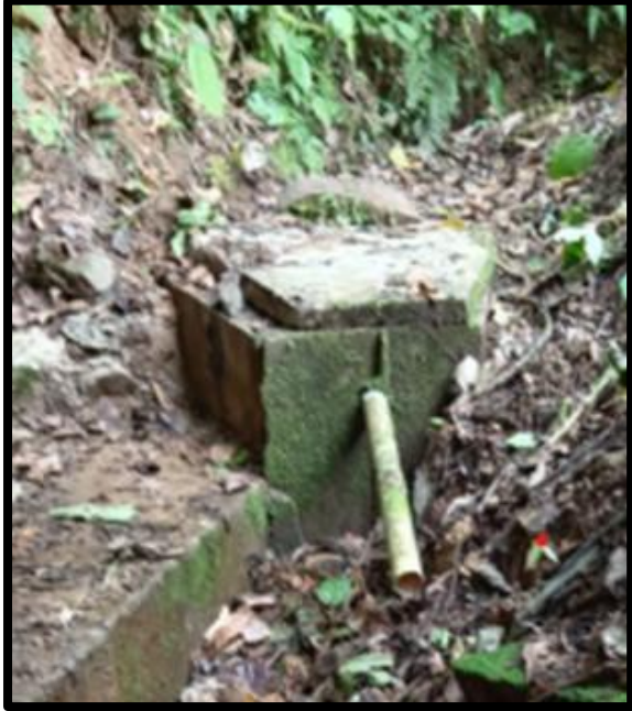
1. Captación del agua
