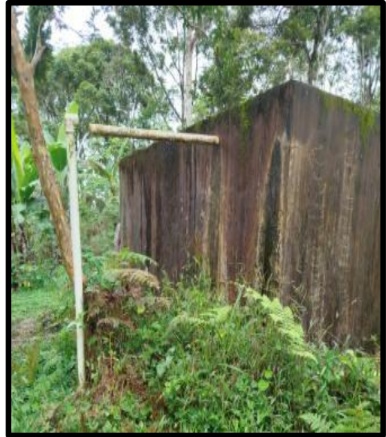
2. Tanque de almacenamiento
