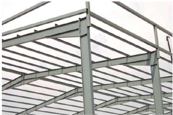
Figura 129. Estructura metálica. Fuente: Ferros la pobla, 2020
