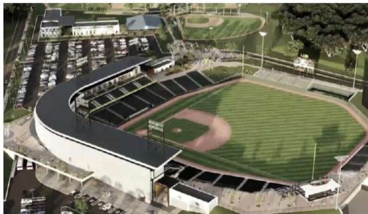
Figura 14. Vista digital del complejo en construcción (render). Betcris, 2023
