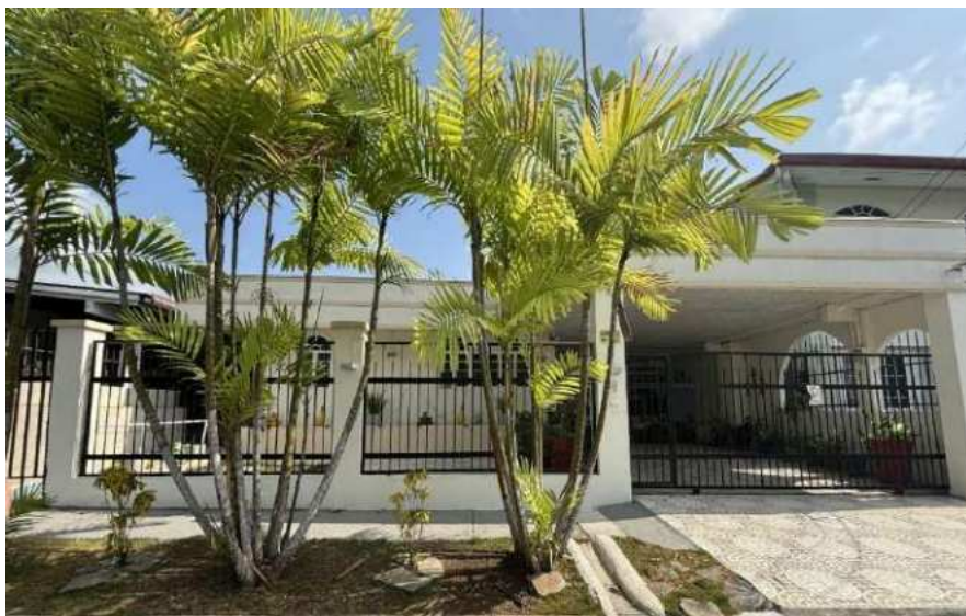
Imagen 22. Vista desde la calle de la Residencia Geriátrica España. Fuente: (Residencia Geriátrica España, 2021)
