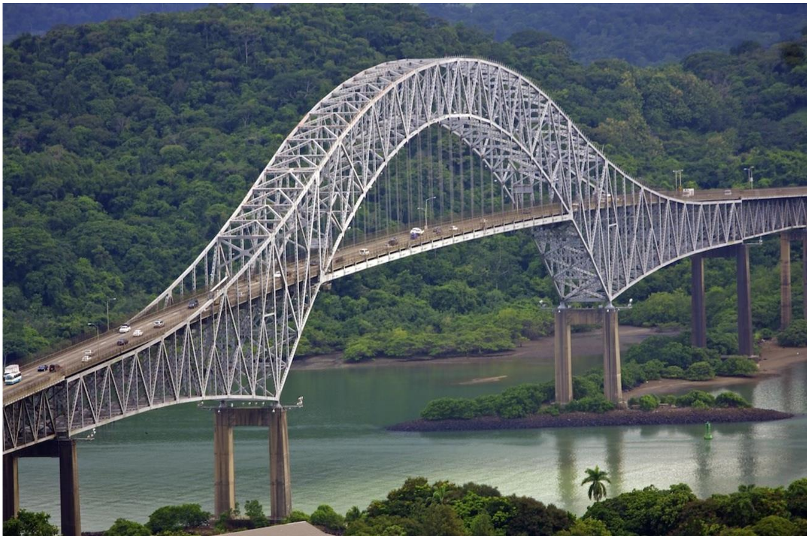
Fig. 1: Puente de las Américas, conexión vial de la Provincia de Panamá Oeste con la Provincia de Panamá
