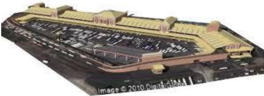
Ilustración 33: Vista de la terminal de Albrook.
