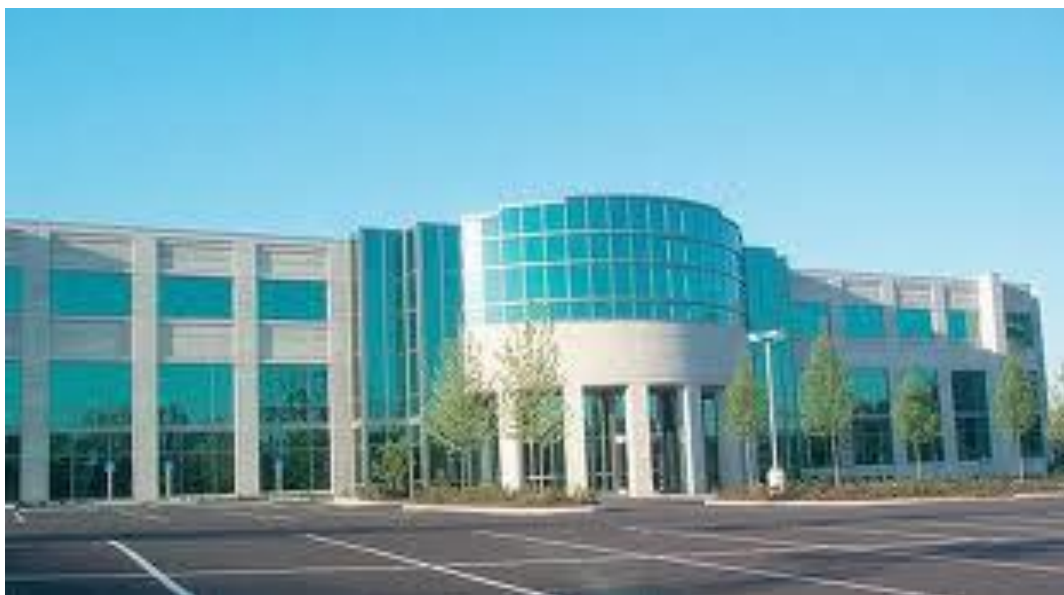
Ilustración 26 Fachada de hormigón con estructura de vidrios
