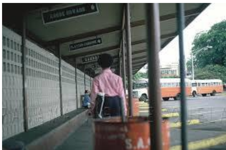
Ilustración 4: Terminal con infraestructuras inadecuadas
