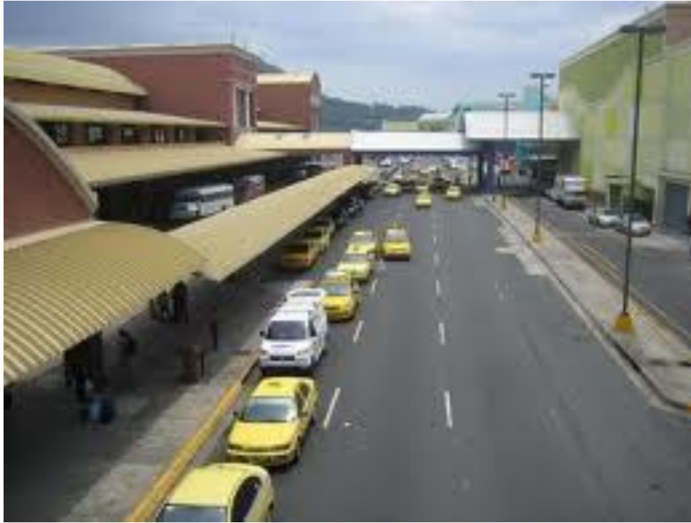
Ilustración 10: Terminal de Albrook
