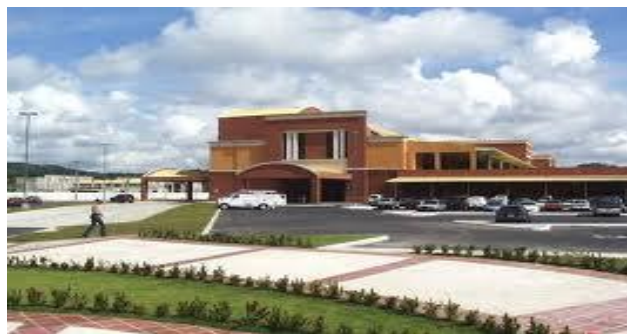
Ilustración 37: Terminal de Albrook
