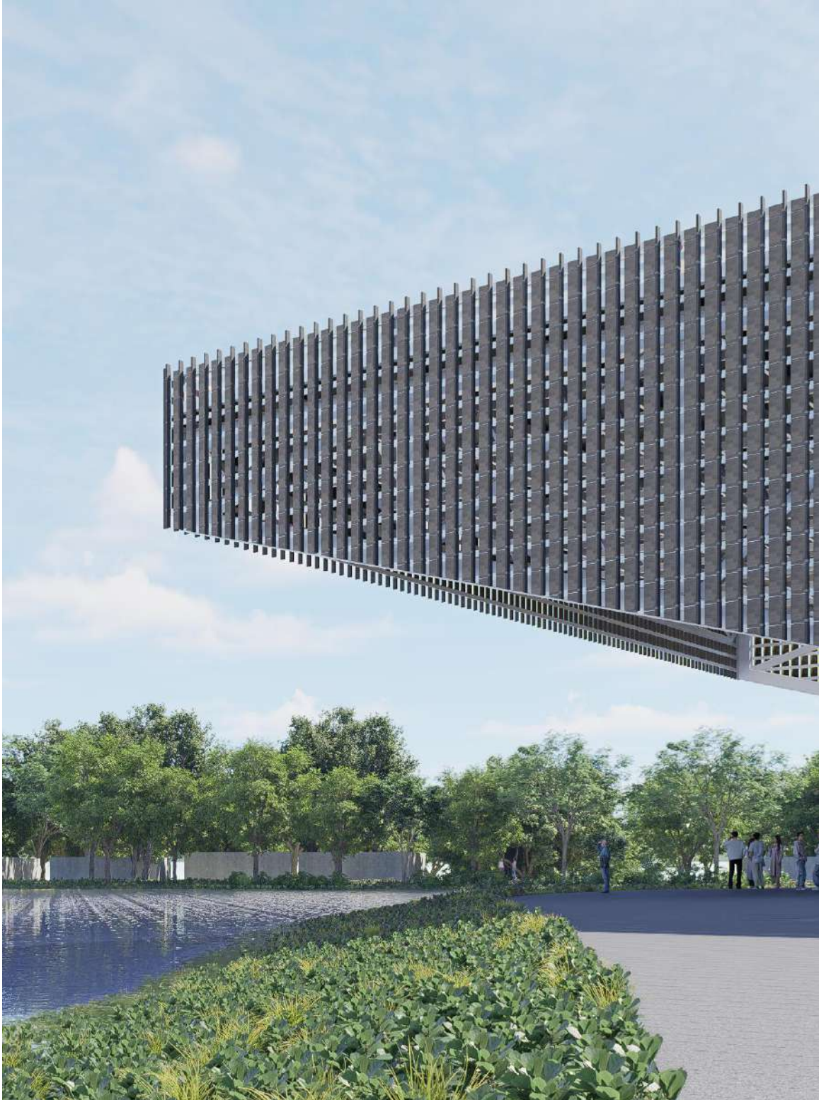
Figura 95. Vista exterior de llegada
