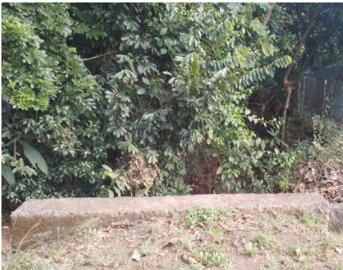
Figura 59. Tubería transversal 1 Fotografía del autor
