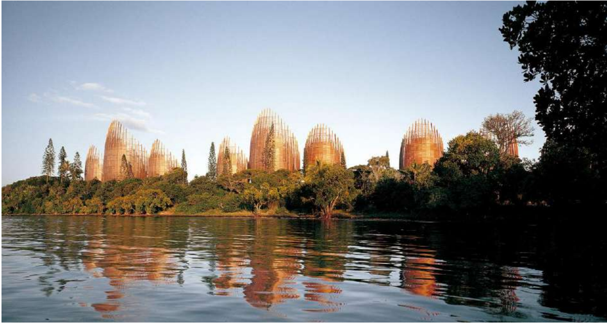
Figura 16. Vista de aproximación al proyecto. Fotografía de John Gollings
