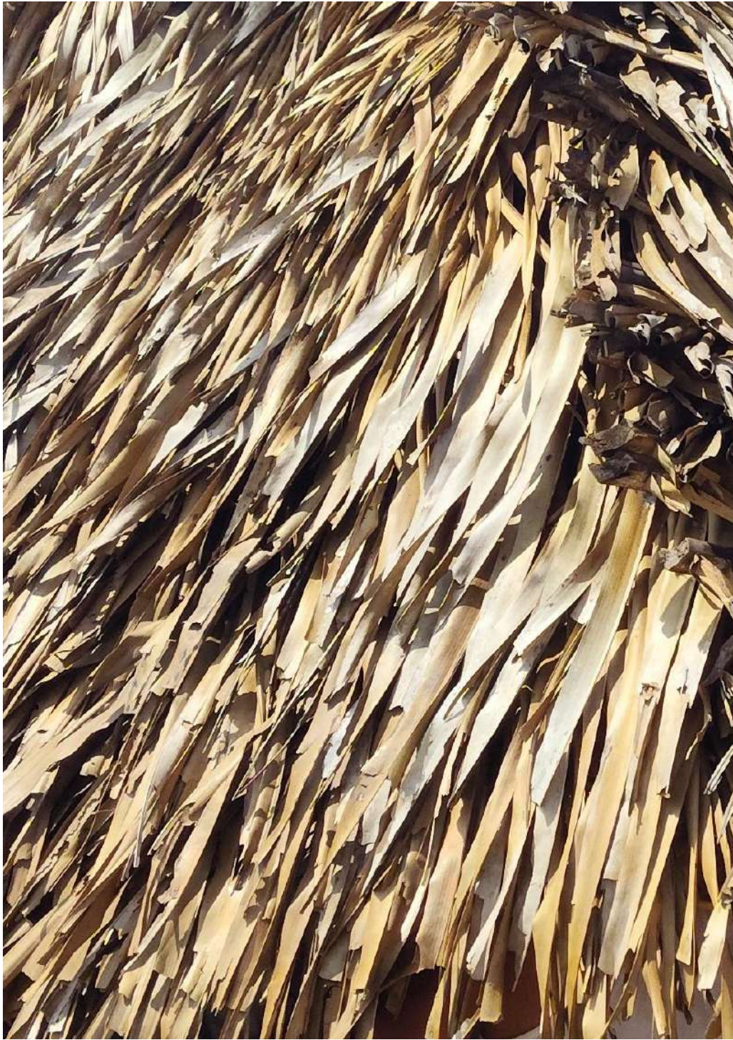
Figura 77. Pencas en cubierta de rancho Fotografía del autor
