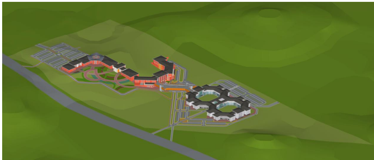
Ilustración 62. Vista general del edificio académico, Puente Central y Clínica Universitaria
