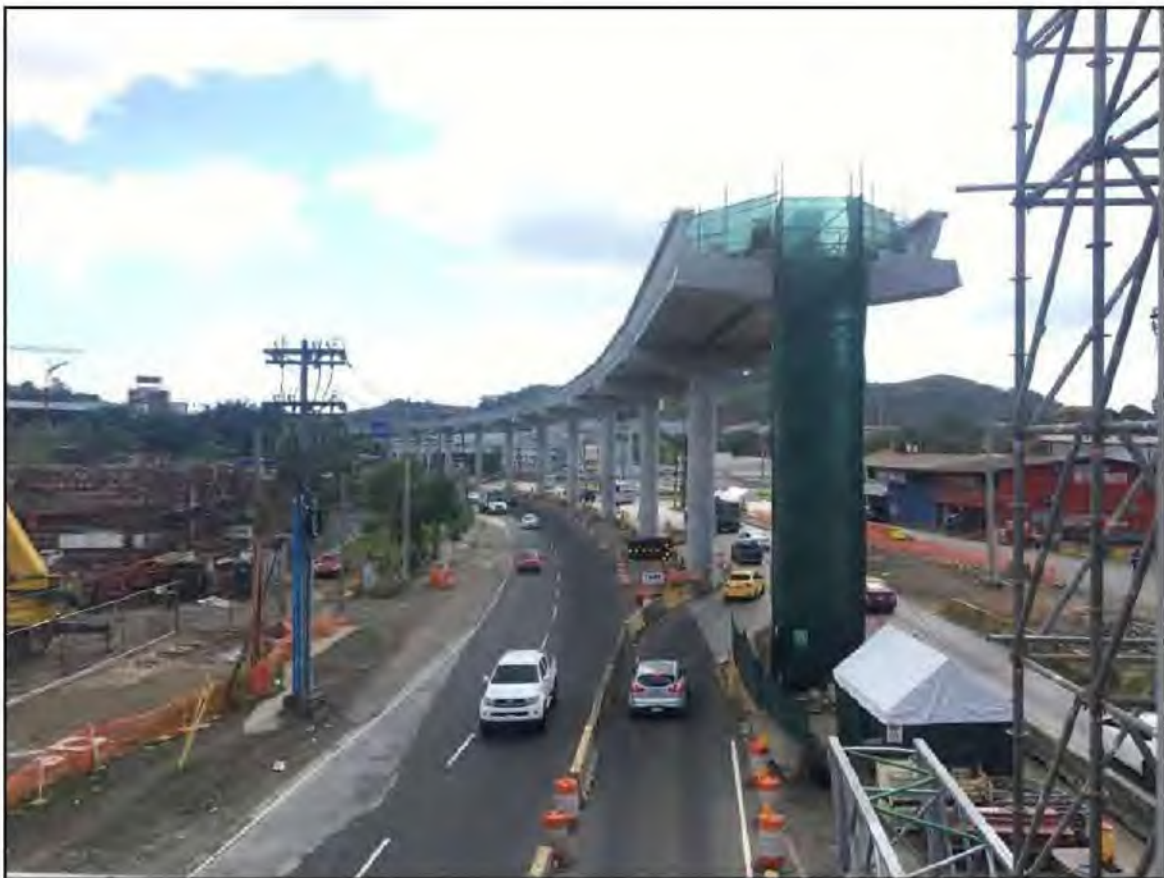
Ilustración 20. Construcción Línea 1 del metro de Panamá.
