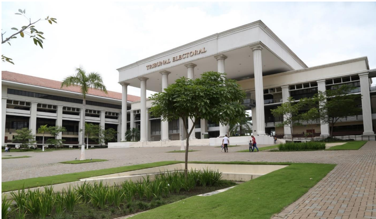
Figura 17. Edificio del Tribunal Electoral
