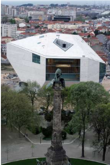
FIG. 37. Vista aérea de la fachada
