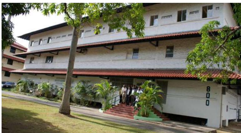
FIG. 2. Edificio 800 en Albrook, antigua sede del conservatorio. El edificio presenta problemas de espacio, problemas en su estructura, falta de estacionamientos, entre otros. (imagen Inac.com)
