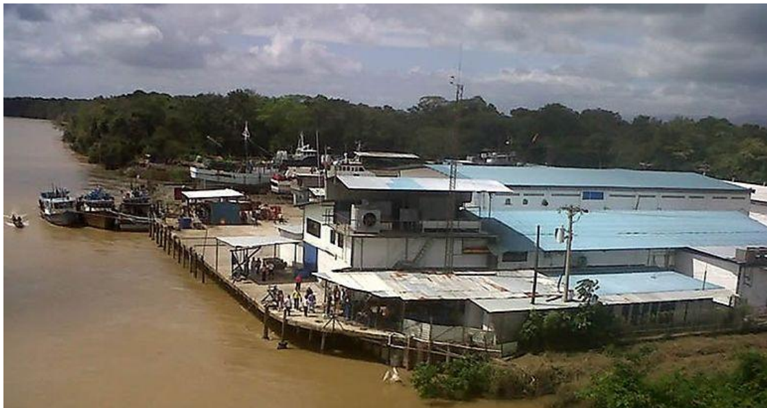
Ilustración 48. Vista del Astillero Bayano. Fuente: Google Imagen.
