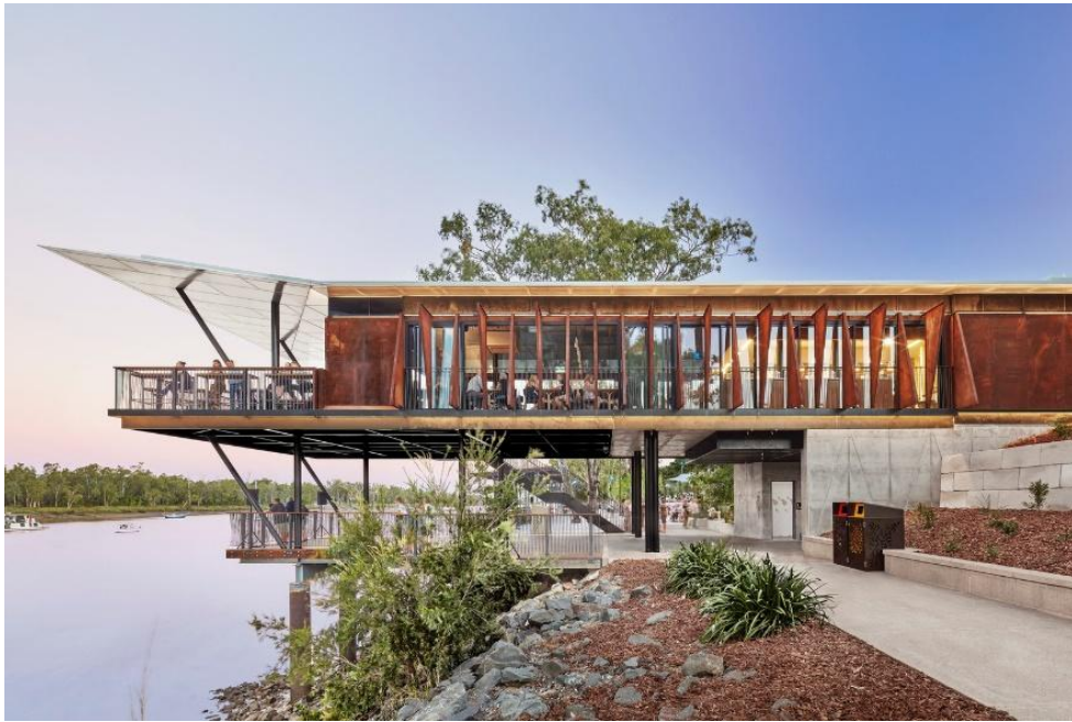
Ilustración 20. Vista lateral derecha del Recinto de Rockhampton Riverside Fuente: ArchDaily en Español.
