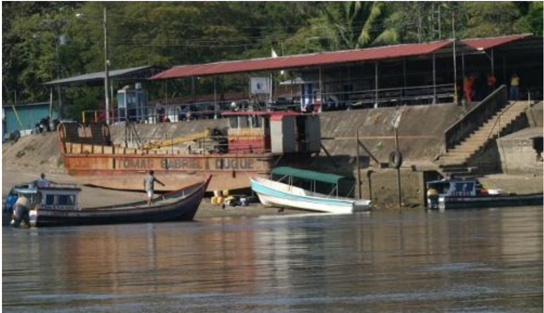
Ilustración 13. Vista de la terminal de pasajeros del puerto Coquira. Fuente: Google Imagen.
