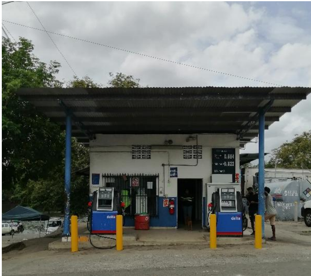
Ilustración 42. Estación de gasolina del puerto Coquira.
