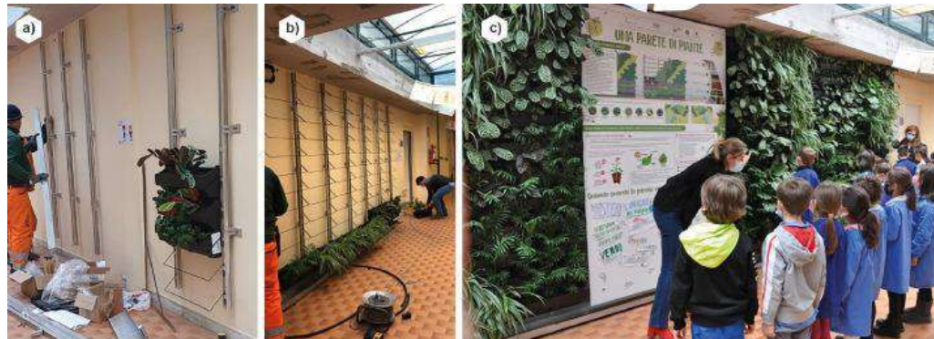
Ilustración 121-Instalación de muro verde
