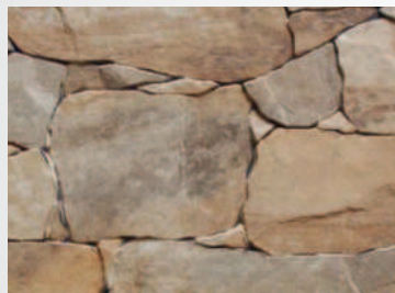
Figura 49. "Revestimiento exterior con aspecto a piedra natural" ©ELMEC | 2025
