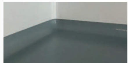
Figura 54. "Curva sanitaria de Mortero de Poliuretano" s,f.
