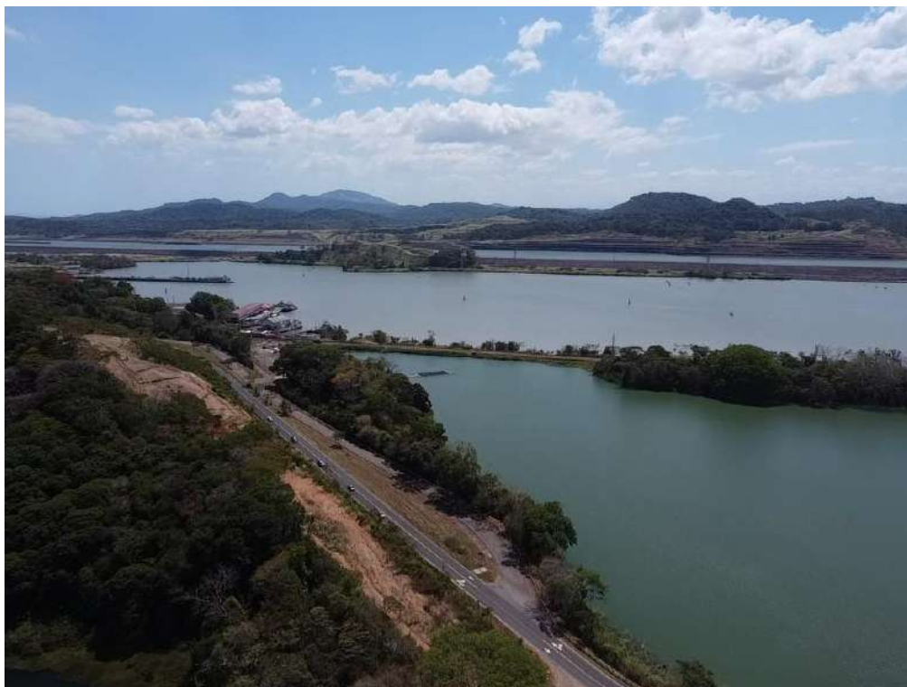
Ilustración 34, Vista aérea desde Lago Brazo Camarón, se puede apreciar: las esclusas de Miraflores, Ave. Omar Torrijos Herrera; al igual que el área donde se realizaba los trabajos de ampliación de esta. Fotografía por el autor.
