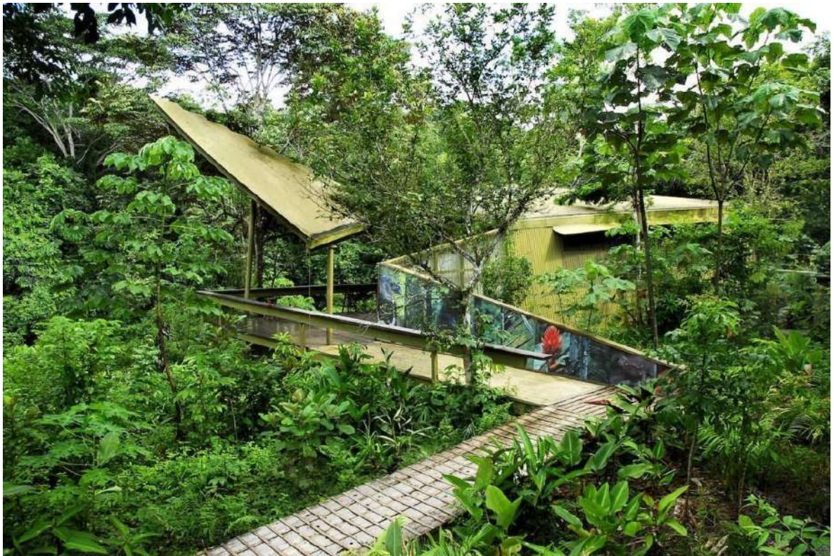
Ilustración 15. Grunhut S. (2012). Centro de Visitantes. [Fotografía]. Arch Daily en español. https://www.archdaily.cl/cl/02-148453/centro-de-visitantes-selva-de-panama-ensitu?ad_source=search&ad_medium=projects_tab
