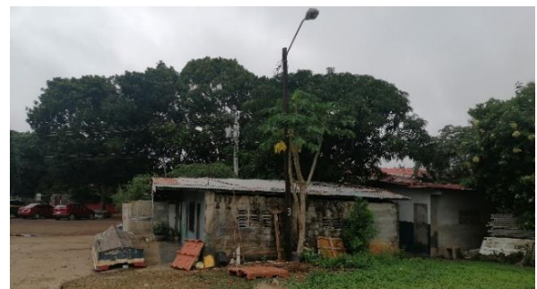
Imagen 17. Vista lateral del restaurante.
