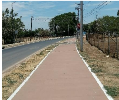
Imagen 61. Ciclovia de la Avenida Ranaldo Camarano.
