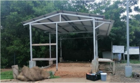
Imagen 14. Concesión en construcción.
