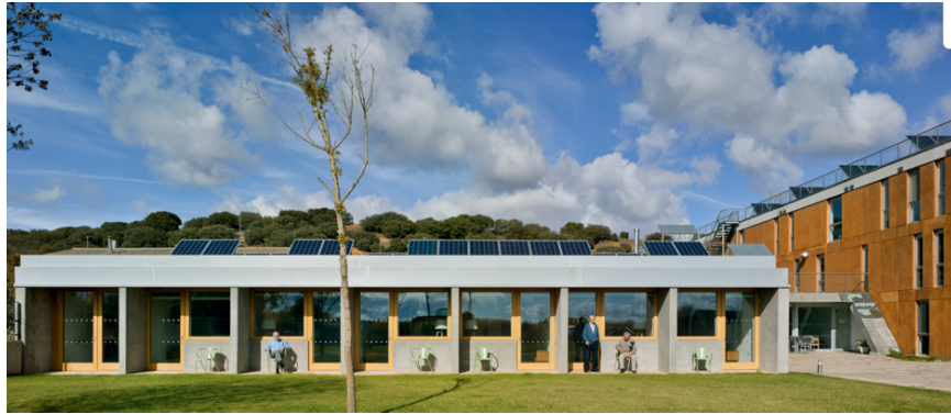
Imagen 5: Instalaciones de Passivhaus
