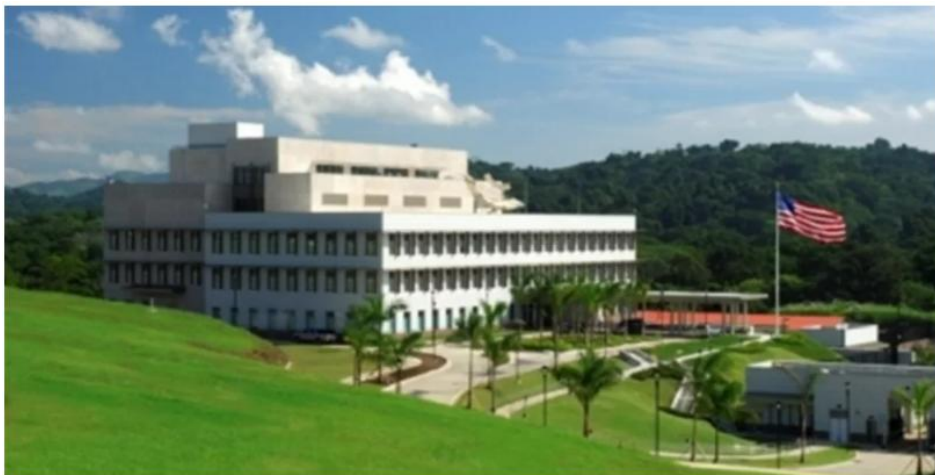
Ilustración 37. Vista lateral del edificio, con voladizos de protección solar, jardines nativos y sistemas de captación pluvial. Fuente: (Leaf Latam. , 2024).
