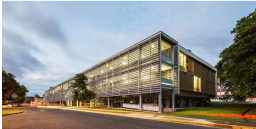
Ilustración 36. Fachada principal de los dormitorios, con aleros profundos, vegetación perimetral y materiales de bajo impacto ambiental.
